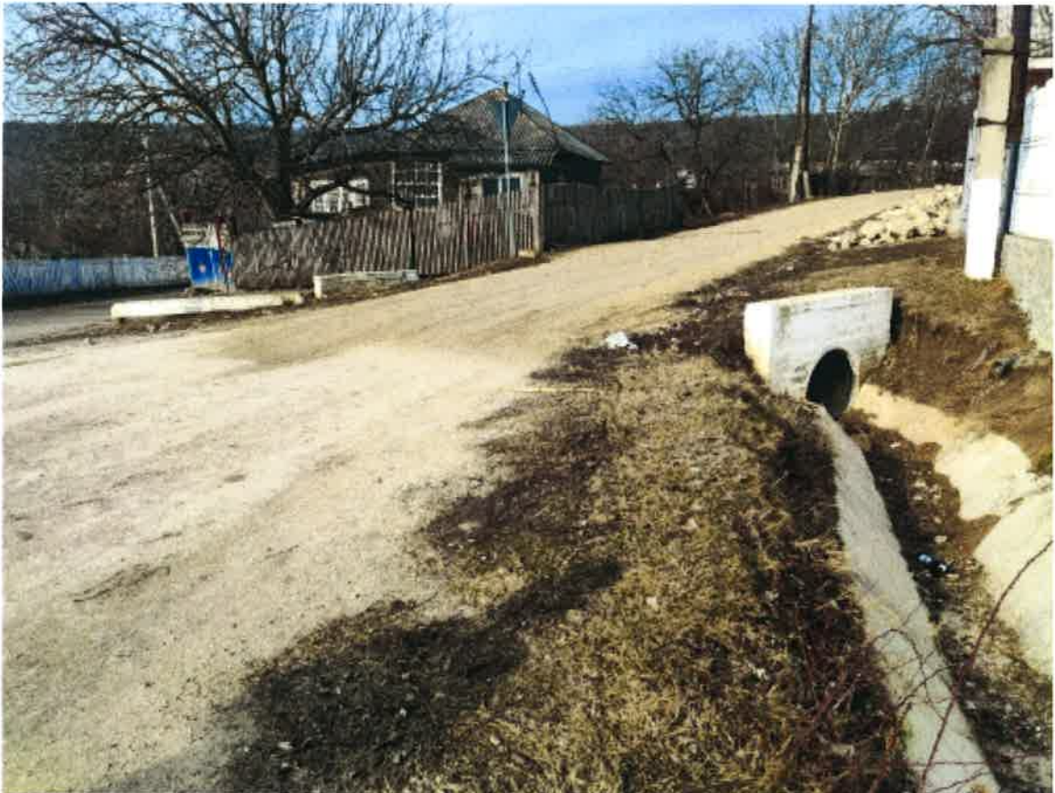
Vedere capăt ieșire podeț
