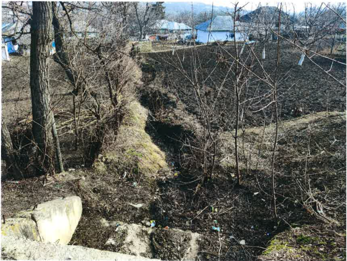
Vedere albie existentă la ieșire podeț
