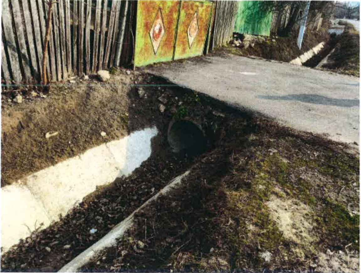
Vedere capăt ieșire podeț
