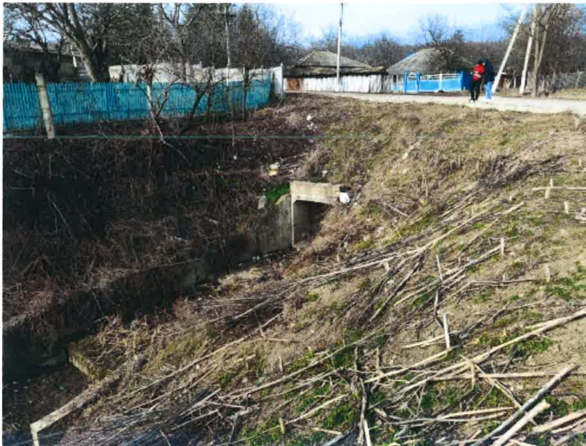
Vedere capăt ieșire podeț
