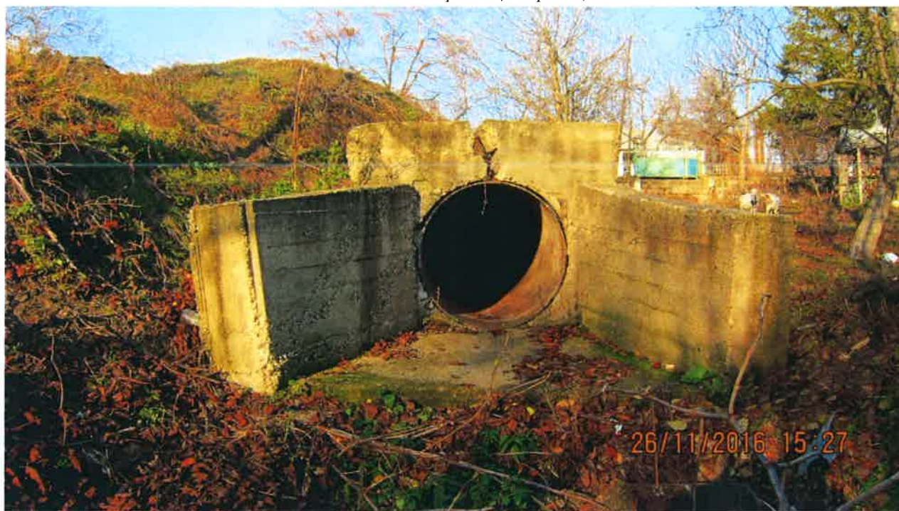
Vedere capăt ieșire podeț
