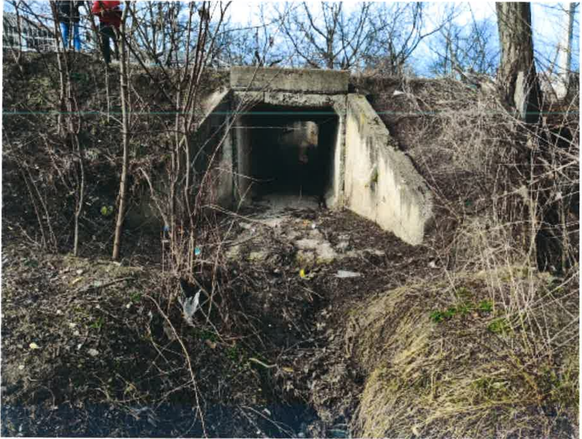
Vedere capăt ieșire podeț
