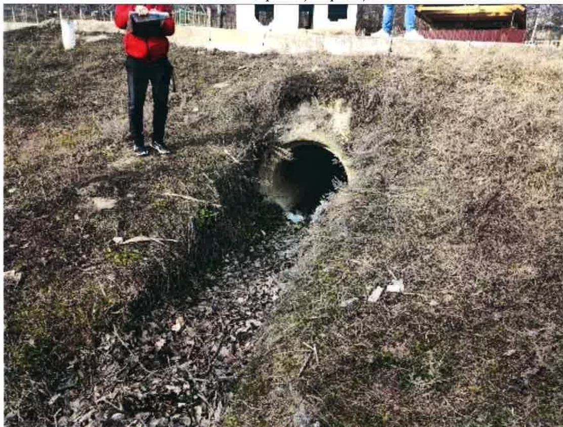
Vedere capăt ieșire podeț
