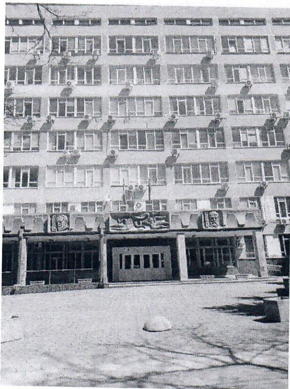
Fațada blocului 1, intrarea principală
