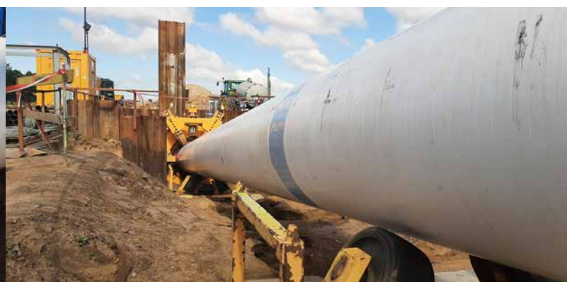
Oczyszczalnia Czajka DN1200, DENSOLID HDD
