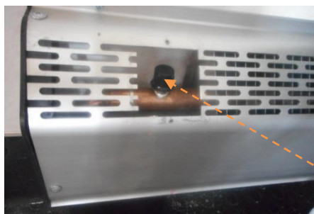
Рисунок 12.4.3.3 Вентиль видалення повітря з опалювачів конвекторного типу
