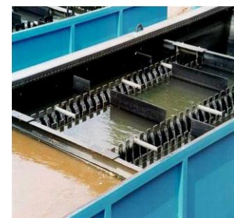
Transferul de apa intre zona de coagulare/floculare si cea de sedimentare se face printr-o camera de liniștire amplasata sub modulul lamelar. Placile inclinate (modulul lamelar) care formeaza celule patrate ajuta sedimentarea si face posibila reducerea zonei de suprafața a structurii.
