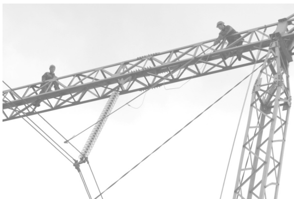
Установка заземления с траверсы
