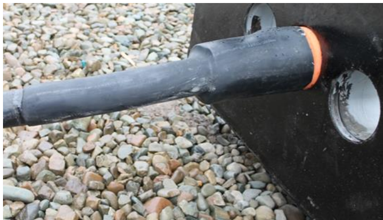
Рис.23 Пример выполнения герметизации кабельного присоединения.
