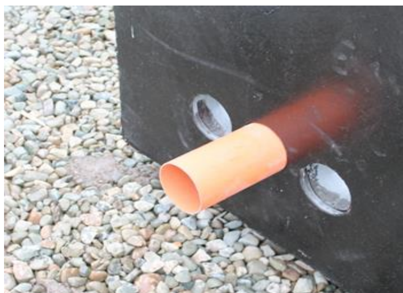
Рис.19 Монтаж пластиковой трубки в корпус фундамента GALBOX.
