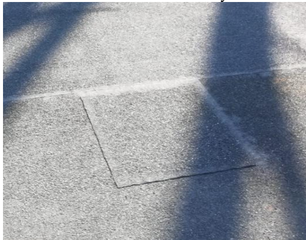
Рис.12 Пример герметизации мест подъема GALBOX.
