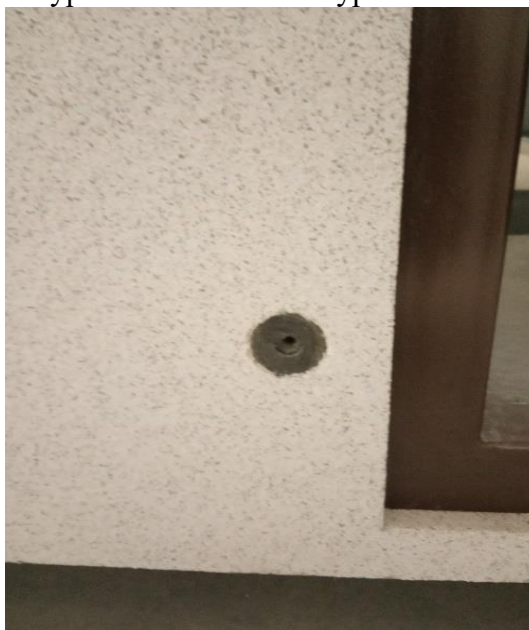
Рис.15 Место подсоединения внешнего контура заземлением к GALBOX.
