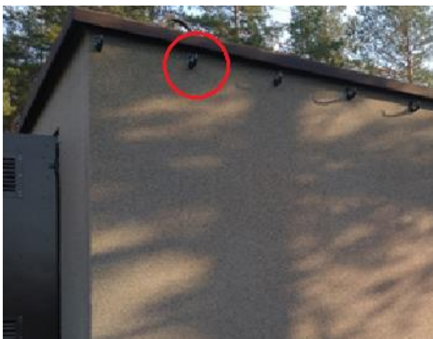
Рис.13 Крепления крюков желоба.
