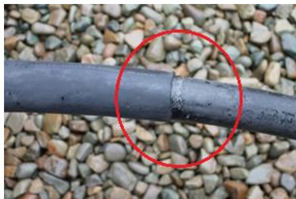
Рис.22 Выделение клея в процессе нагрева термоусадочной трубки
