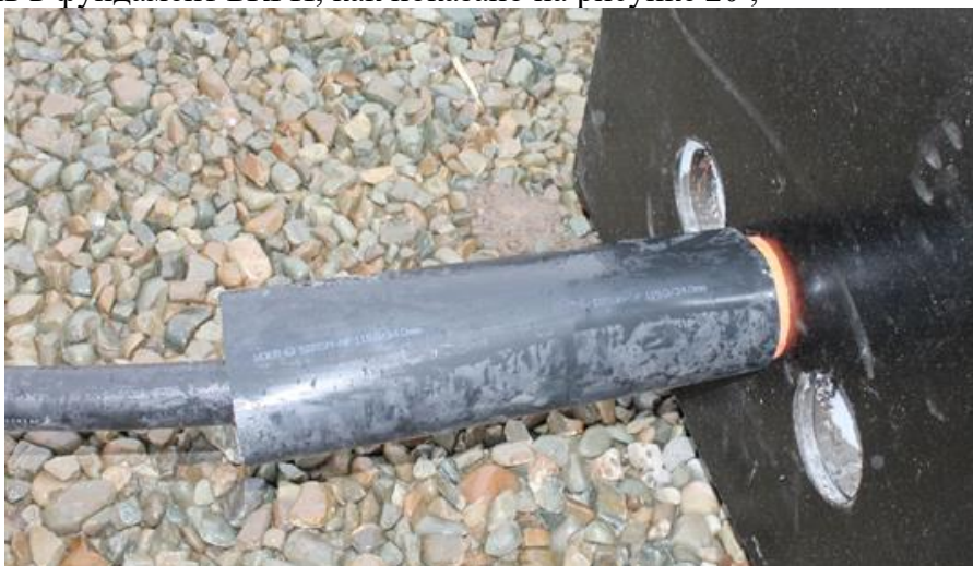
Рис.20 Монтаж кабеля в фундамент БКРП
