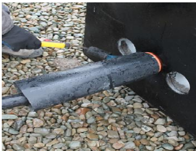
Рис.21 Нагревания термоусадочный трубки
