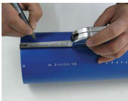
Măsurați și marcați țeava
