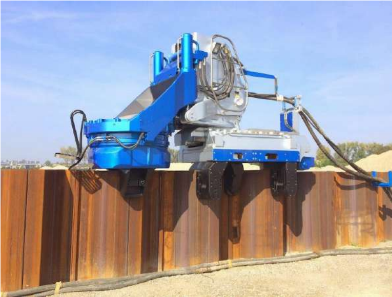
Presă Silent Piler ZU-100 - standard mode
