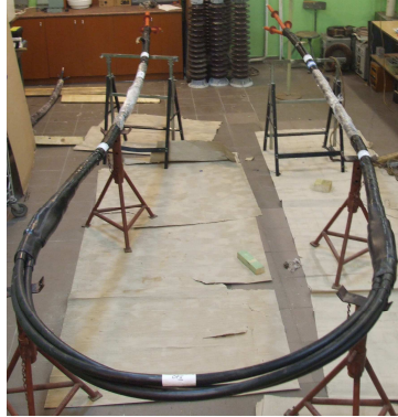
Fotografia 1. Widok odcinka probierczego nr I
