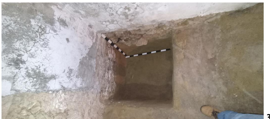
Fig.7. Imagini cu sondajul A din subsolul edificiului A
