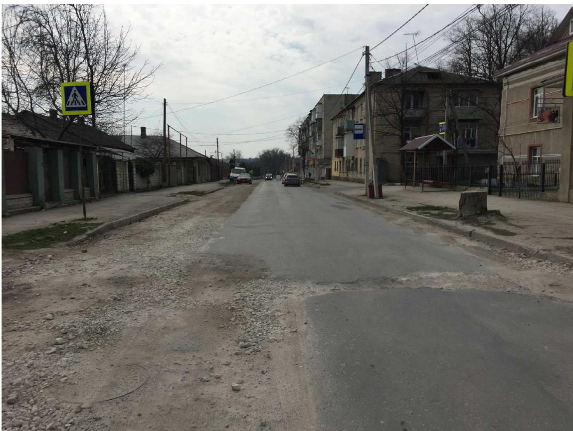
**Рис.8. Состояние асфальтобетонного покрытие проезжей части улицы и засыпанная щебнем траншея водопровода.**
