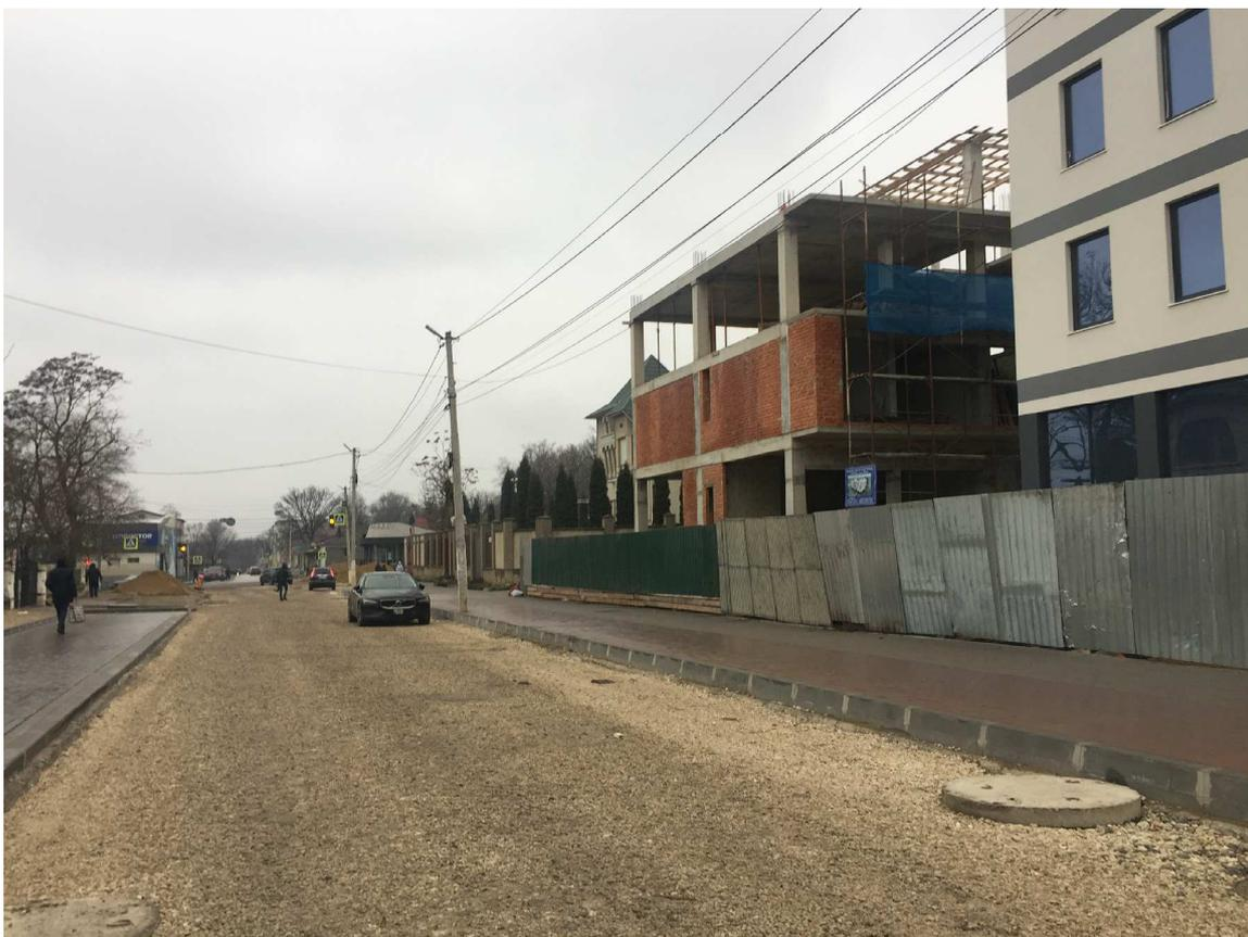
**Рис.7. Щебеночное основание дороги, велодорожка справа и не завершённые ливнеприёмные колодцы построенные на I этапе строительства**
