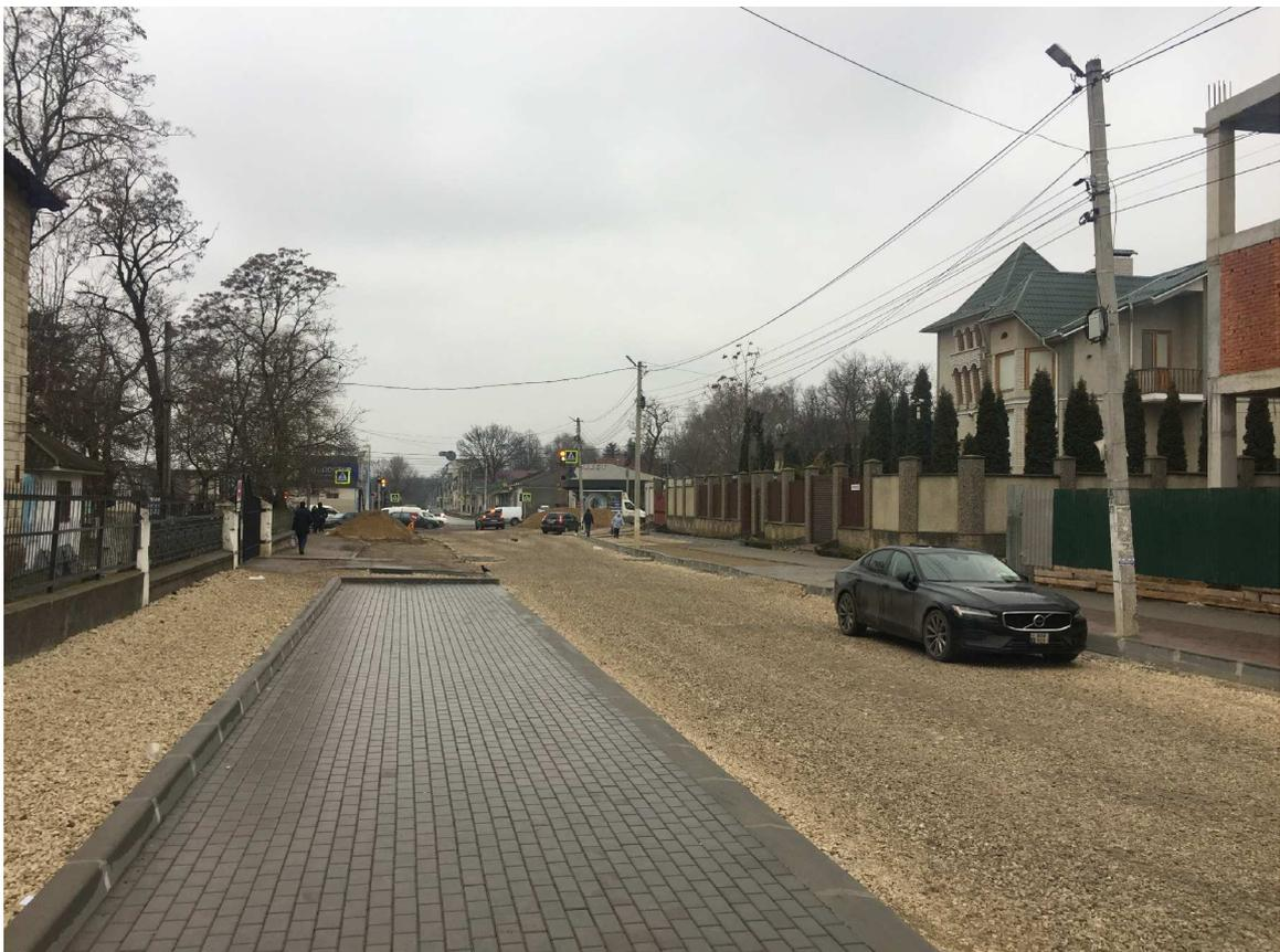
**Рис.6. Конец построенной парковки слева, а также наблюдаем уложенное щебёночное основание на I этапе строительства**
