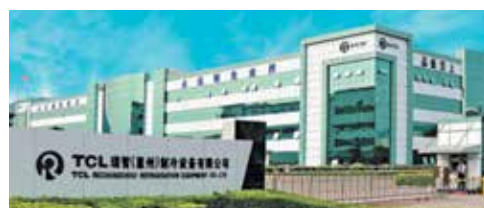
6 Завод СП «TCL – Reichl Compressor» (16 млн. компрессоров для кондиционеров)
