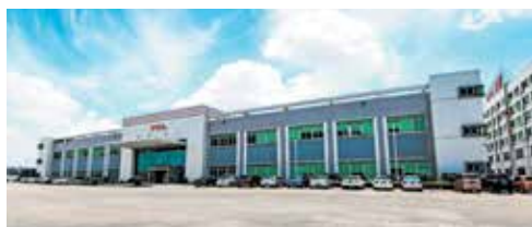
3 Завод в г. Цзюцзян (2 млн. комплектов кондиционеров)
