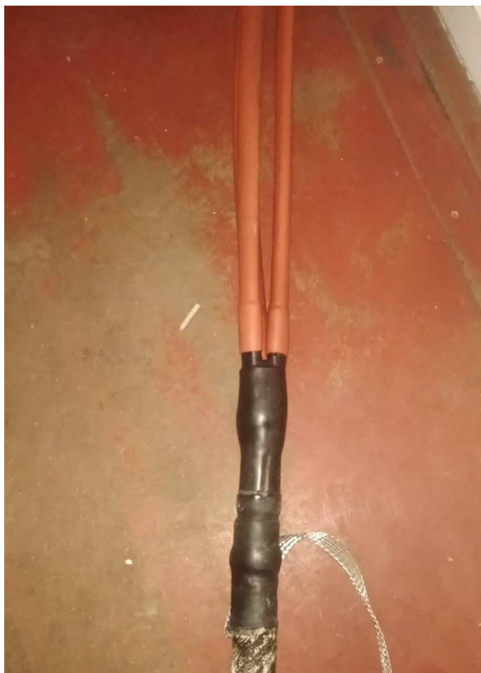
Рисунок 8.2 – Загальний вигляд термоусаджувальних кінцевих муфт типу 10KV(H)TP (зовнішнього та внутрішнього встановлення).
