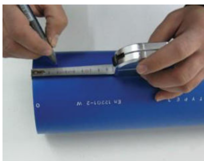
Măsurați și marcați țeava
