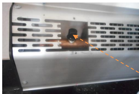
Рисунок 12.4.3.3 Вентиль видалення повітря з опалювачів конвекторного типу
