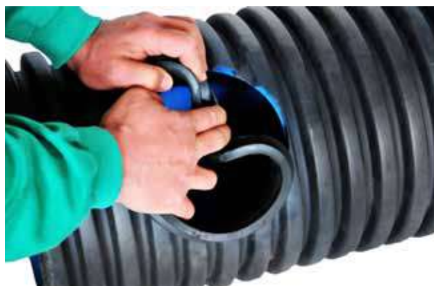
4. Se poziționează conectorul lateral
