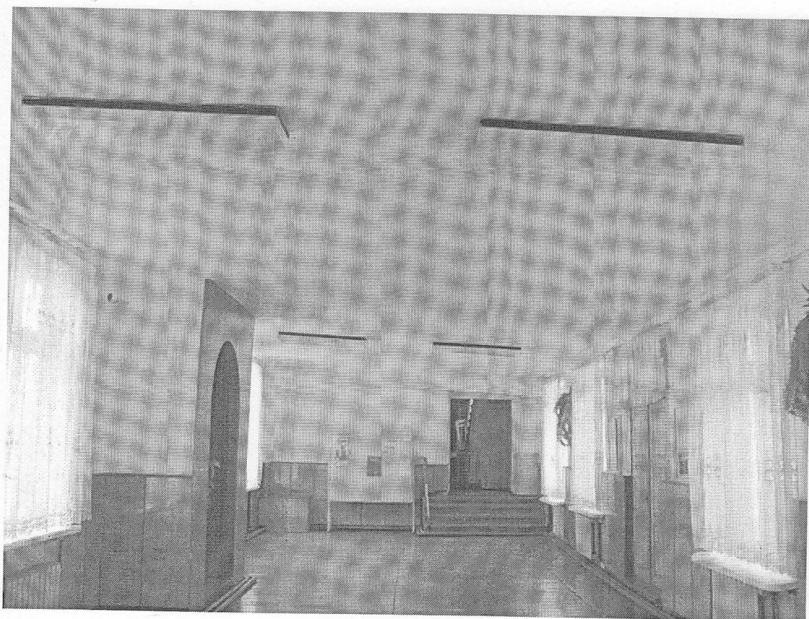
Anexa nr.21. Fațada principală și vederea din interior a blocului lit.A5
