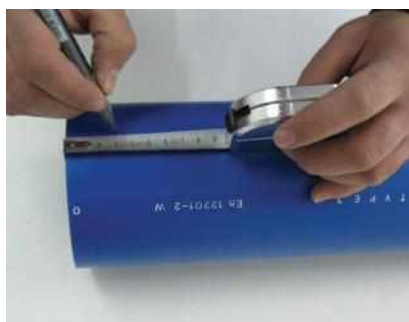
Măsurați și marcați țeava
