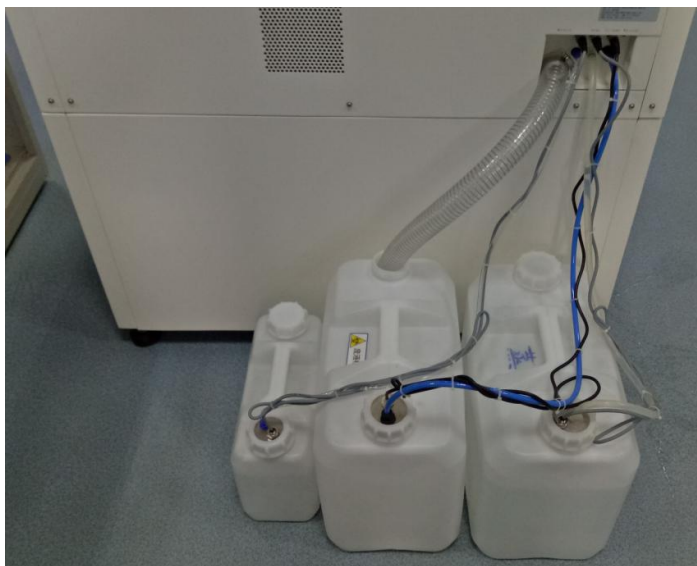
图 4-15 管路线路整理
