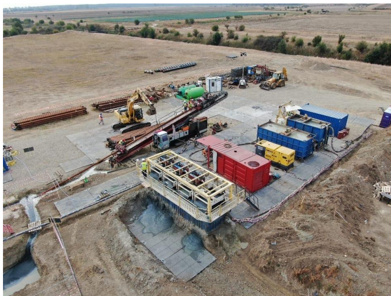
Exemplu platforma intrare foraj
