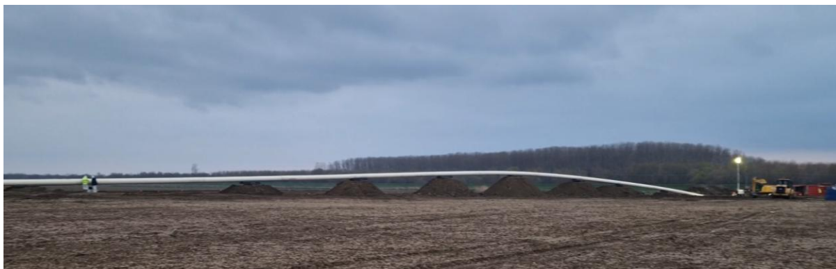
Constructie overbend si pozitionare conducta pe role pe platforma de iesire
