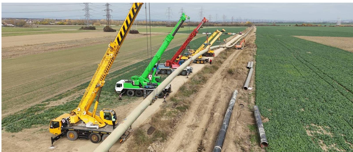
Realizare overbend prin folosire sistemelor de role speciale si a automacaralelor
