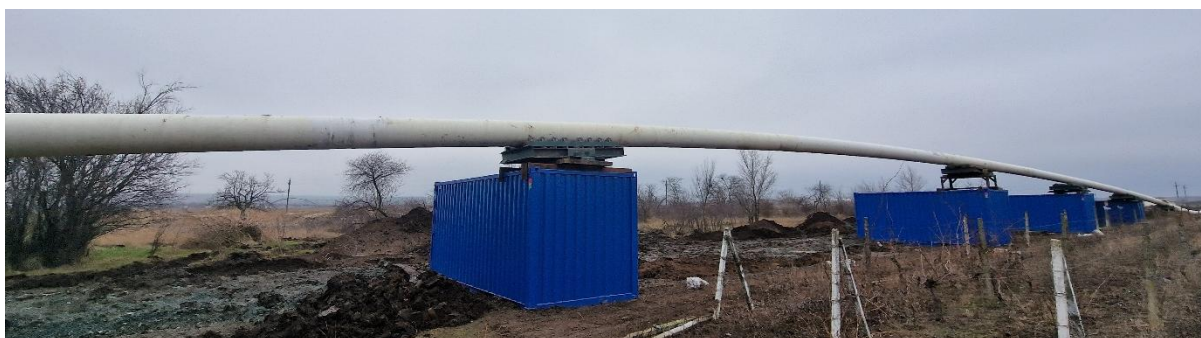
Constructie overbend si pozitionare conducta pe role folosind suportii din containere metalice
