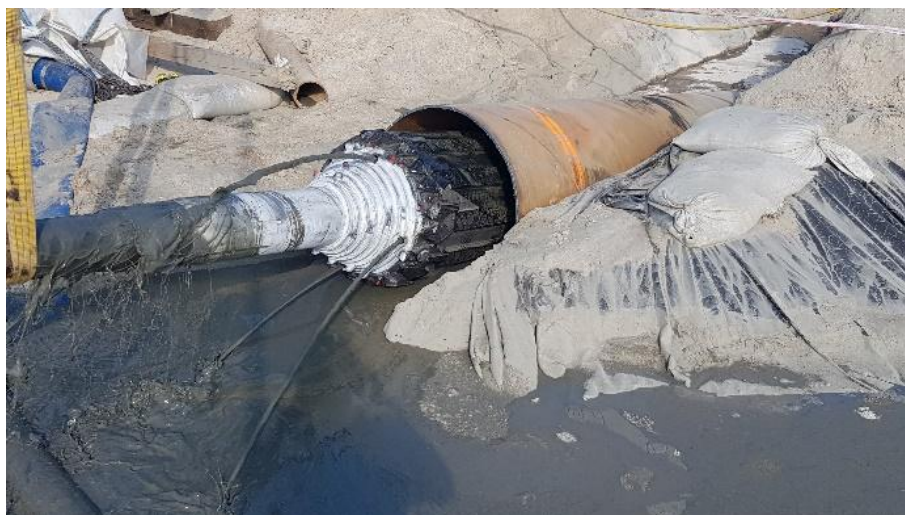
Exemplu curatare tub protector cu largitor de foraj (sol nisp / argila )
