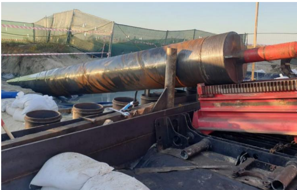
Instalare de tub protector cu ajutorul utilajului de foraj
