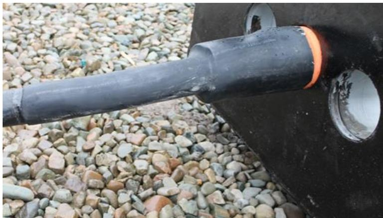
Рис.23 Пример выполнения герметизации кабельного присоединения.
