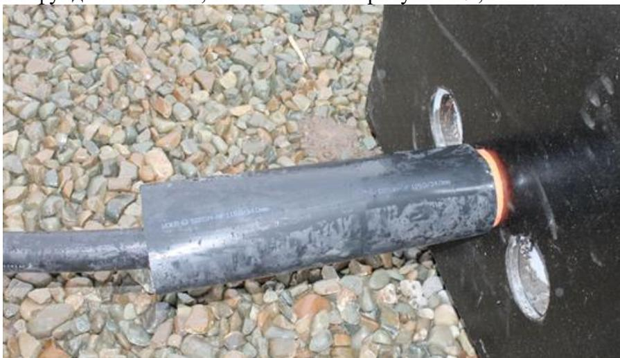
Рис.20 Монтаж кабеля в фундамент БКРП
