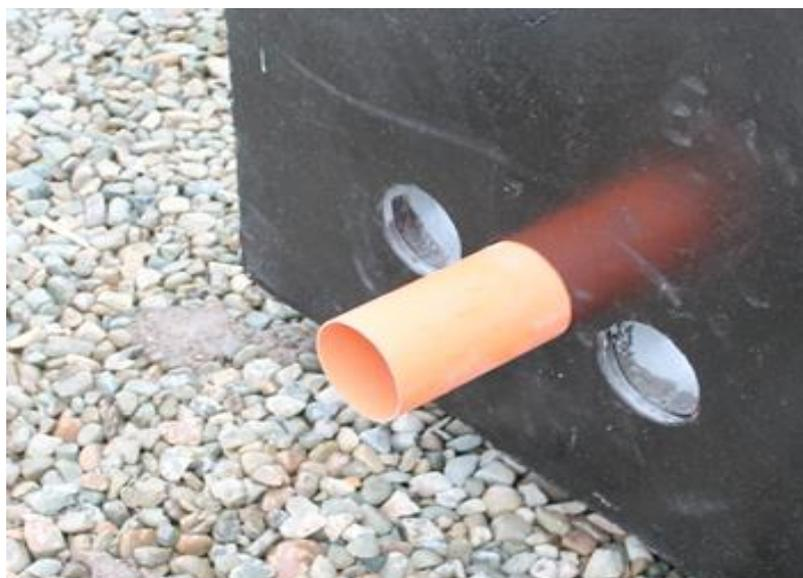
Рис.19 Монтаж пластиковой трубки в корпус фундамента GALBOX.
