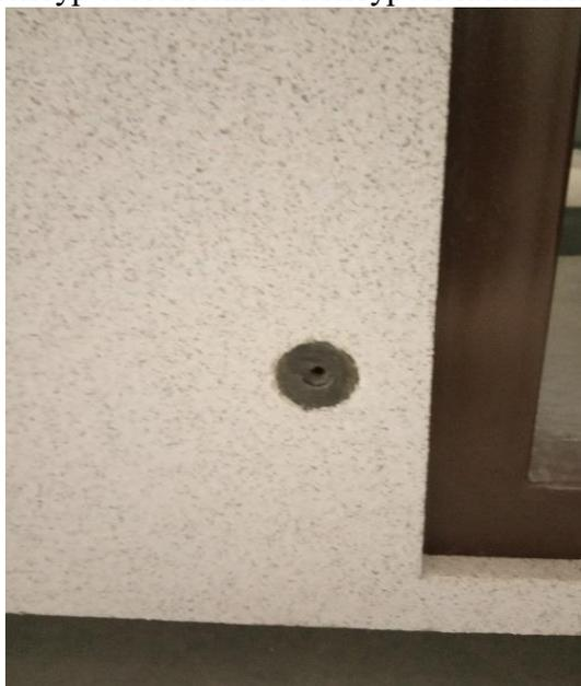
Рис.15 Место подсоединения внешнего контура заземлением к GALBOX.
