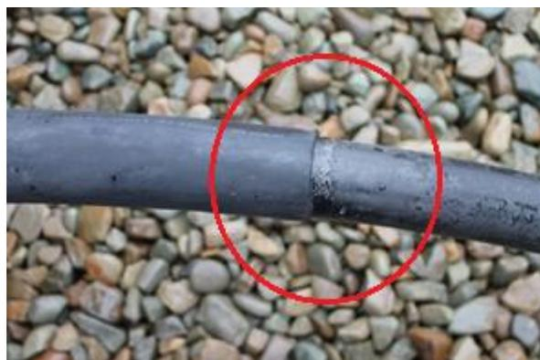
Рис.22 Выделение клея в процессе нагрева термоусадочной трубки
