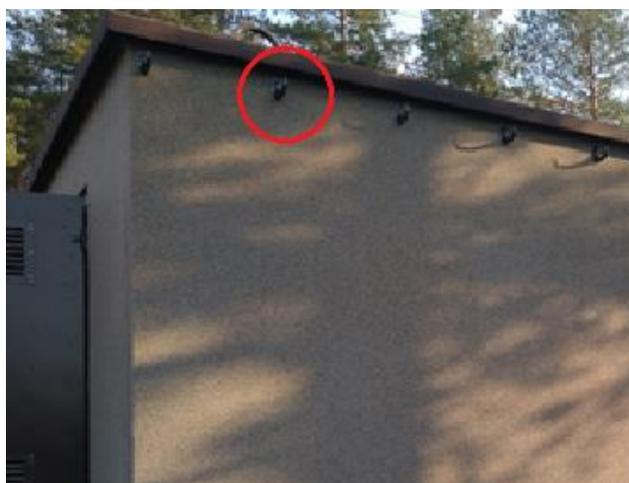
Рис.13 Крепления крюков желоба.
