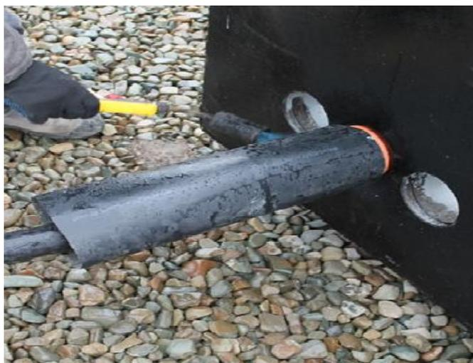
Рис.21 Нагревания термоусадочный трубки
