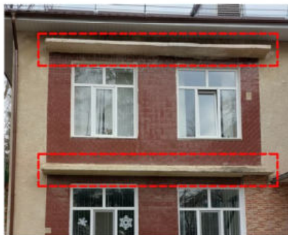
Demontarea parasolarelor din beton
