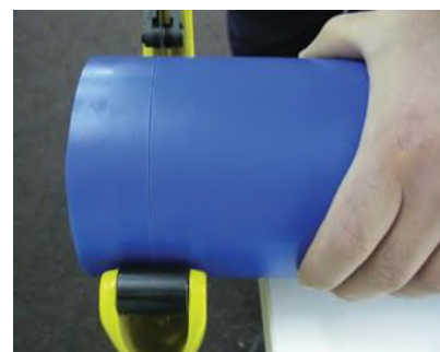
Cu mișcare circulară ușoară, tăiați stratul exterior din PP
