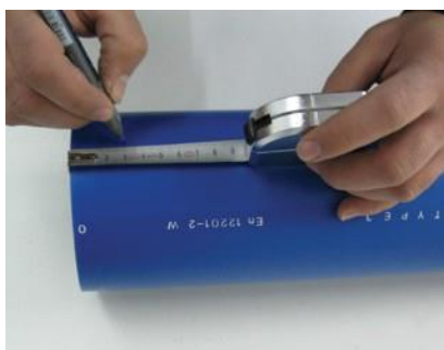
Măsurați și marcați țeava
