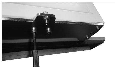
29. Remontați placa de blocare a mânerului de jos în partea opusă strângând din nou cele două șuruburi (utilizați cheia hexagonală de 4 mm)
