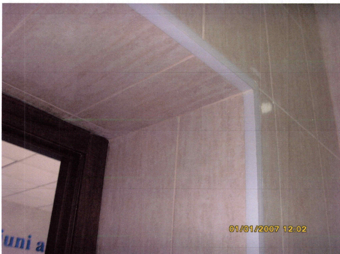
c: Anexa 3: Clădirea administrativă cu nr. cadastral 0100208.435.01 (lit. A), în volumului examinat, din str. A. Mateevici, 10, sect. Centru, mun. Chișinău.
