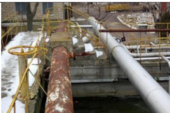
Starea actuală a stației de epurare Florești
