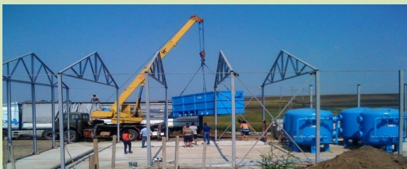
Proces de construcție a stației de tratare
