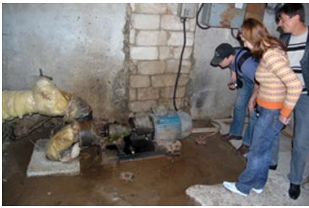
Satul Drepcăuți, examinarea rezervorului de apă potabilă
