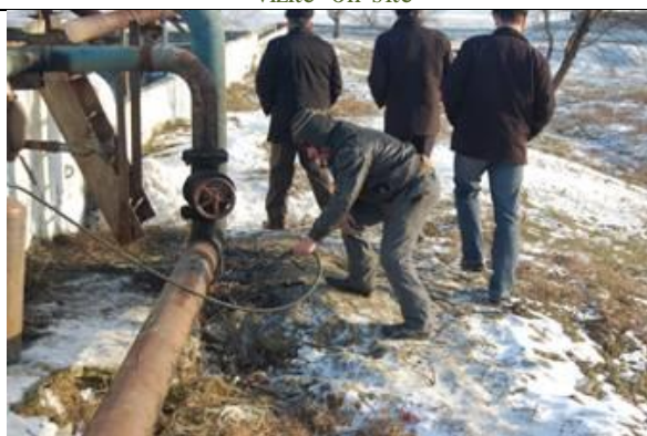
Lucrări la stația de epurare din Fălești
