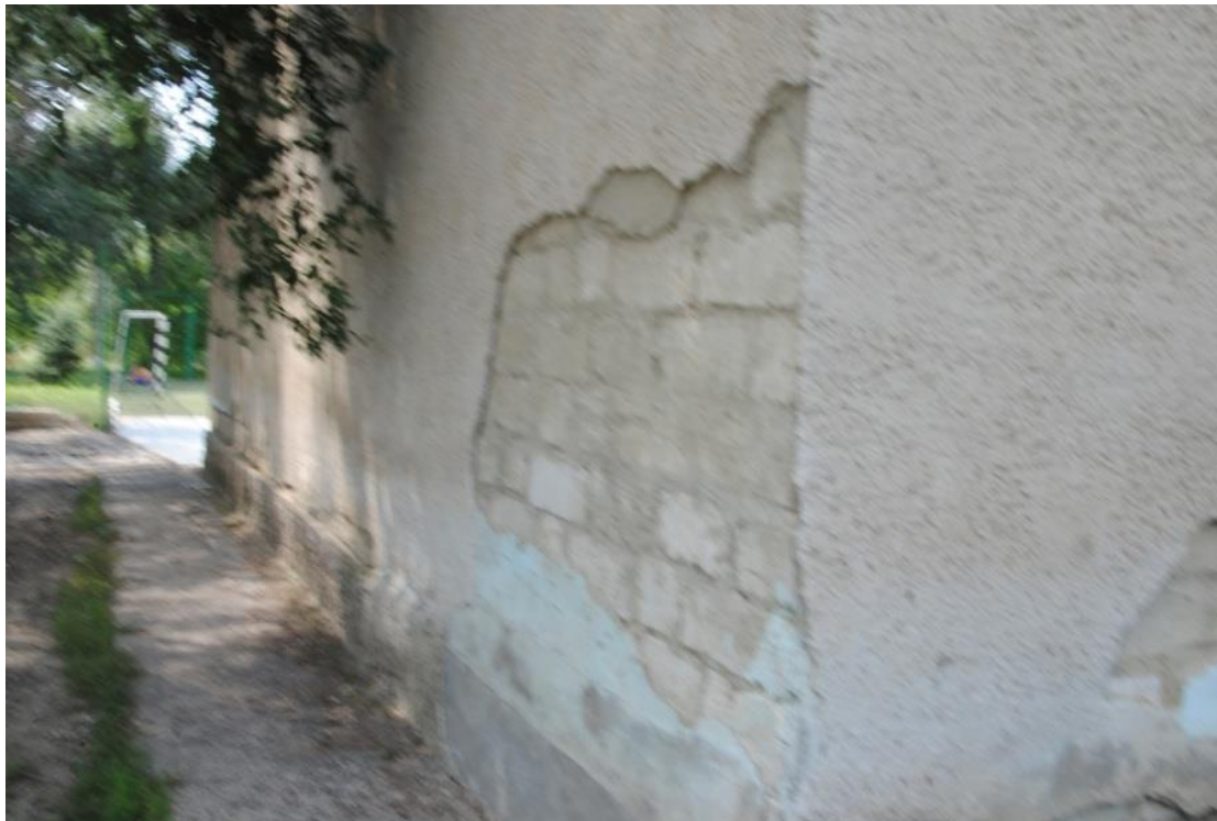
Figura 16 . Vedere perete fațadă .
