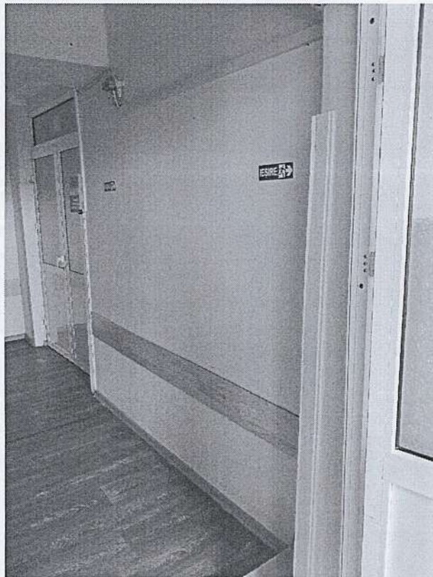
Foto nr. 8. Gol de acces (înzidit) de la etajul 2, în peretele structural, transversal autoportant.
