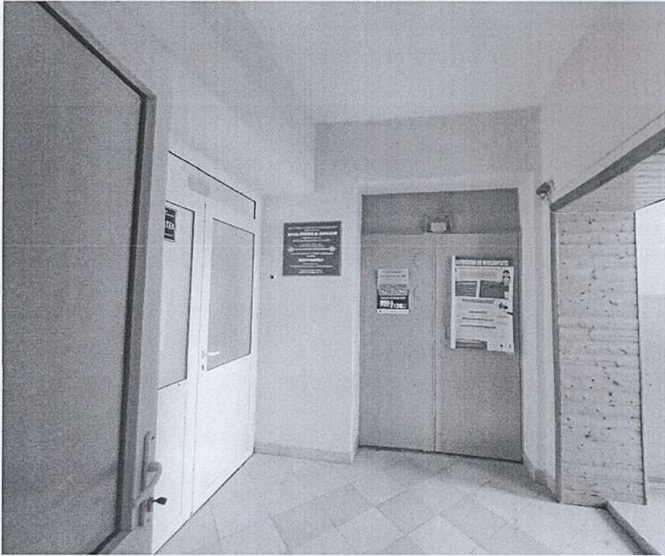
Foto nr. 7. Gol de acces cu ușă metalică de la etajul 1, în peretele structural, transversal autoportant.
