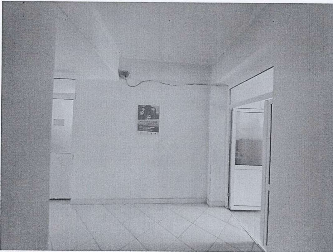
Foto nr. 6. Gol de acces (înzidit) de la parter, în peretele structural, transversal autoportant.
