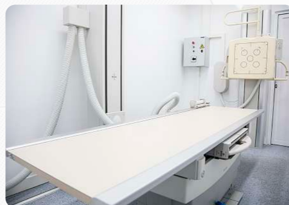
Sala de radiología | Radiology room
