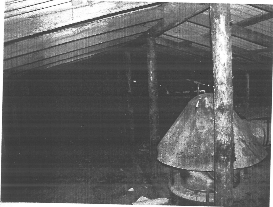
Anexa 3: Execuție acoperiș.
