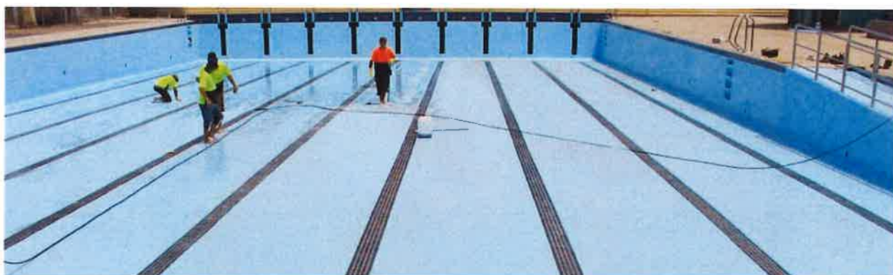
Figura 4. Albia bazinelor după renovare
