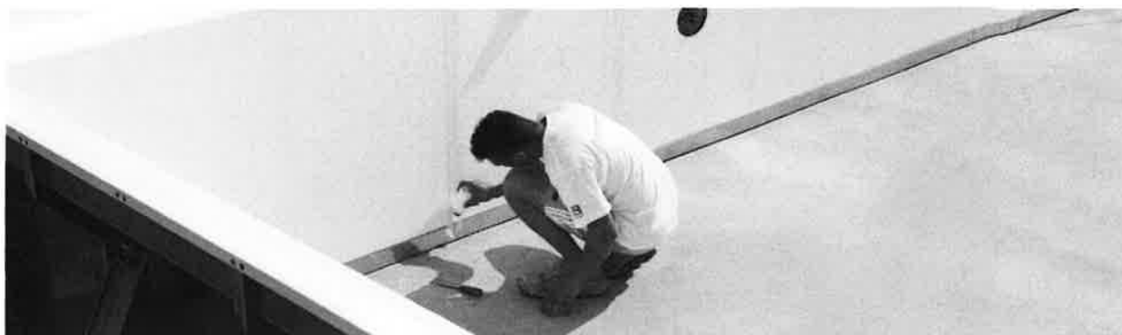
Figura 6. Lipirea plăcilor din oțel inoxidabil
