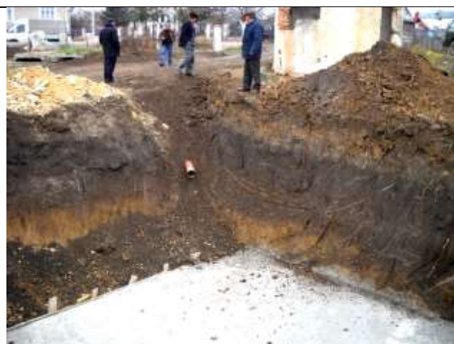
Pregătirea terenului pentru amplasarea SEB
