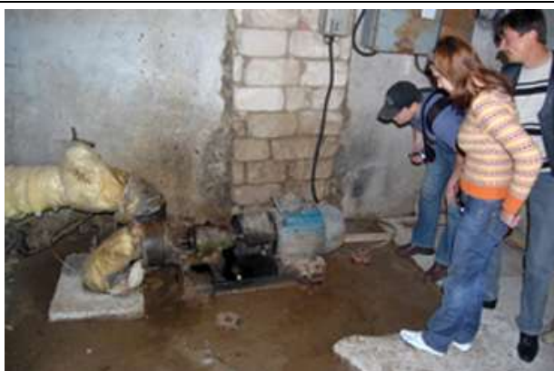
Satul Drepcăuți, examinarea rezervorului de apă potabilă
