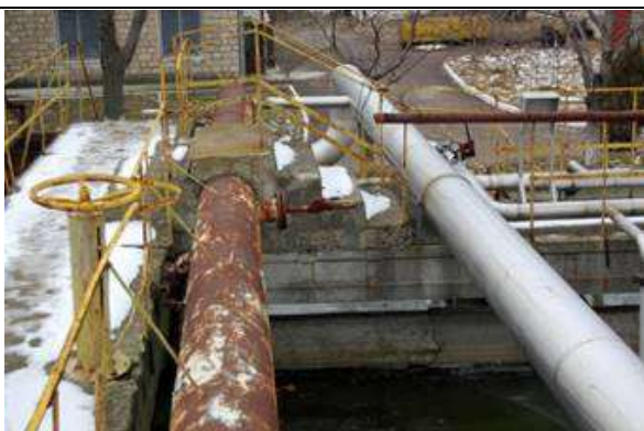
Starea actuală stației de epurare Florești
