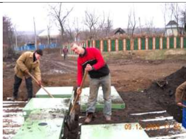
Finalizarea lucrărilor de instalare a stației
