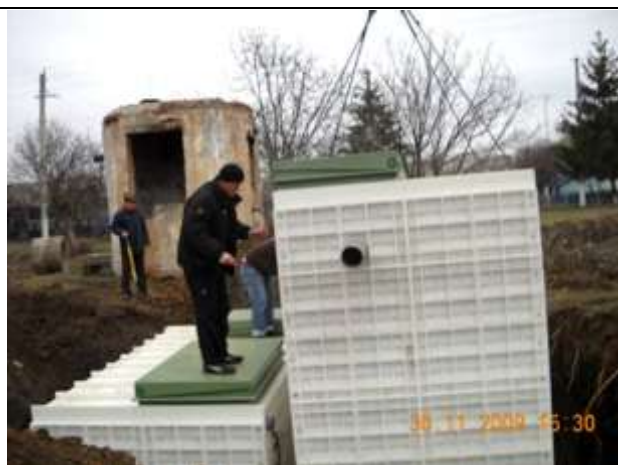
Instalarea stației de tip Topas
