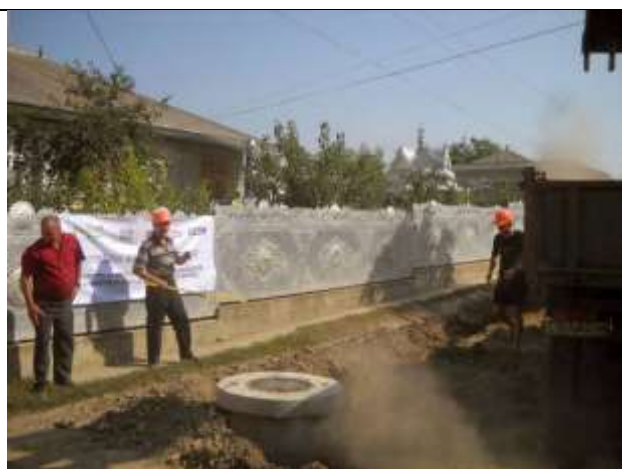
Instalarea rețelei de canalizare
