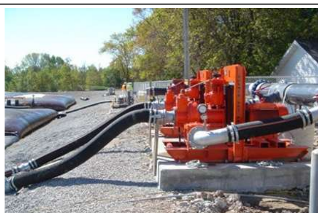
Pompele utilizate la tehnologia Geotube®
