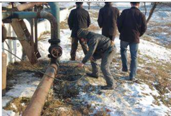
Lucrări la stația de epurare din Fălești
