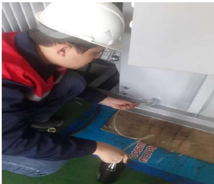
Рисунок 4.7 Отбор масла с бака трансформатора
