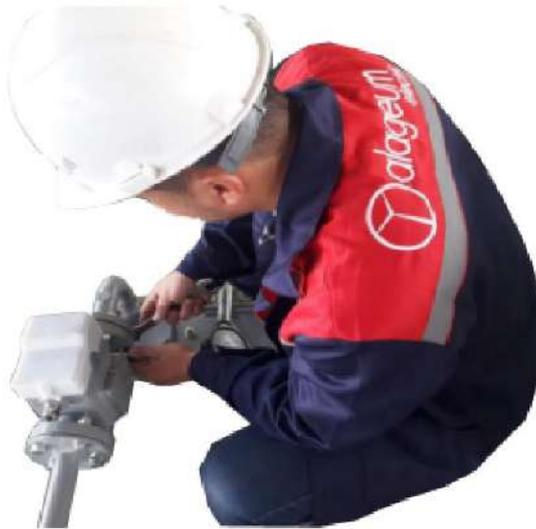
Рисунок 4.11 Установка струйного реле
