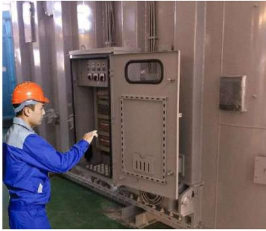
Рисунок 4.16 Монтаж кабелей на клеммную коробку
