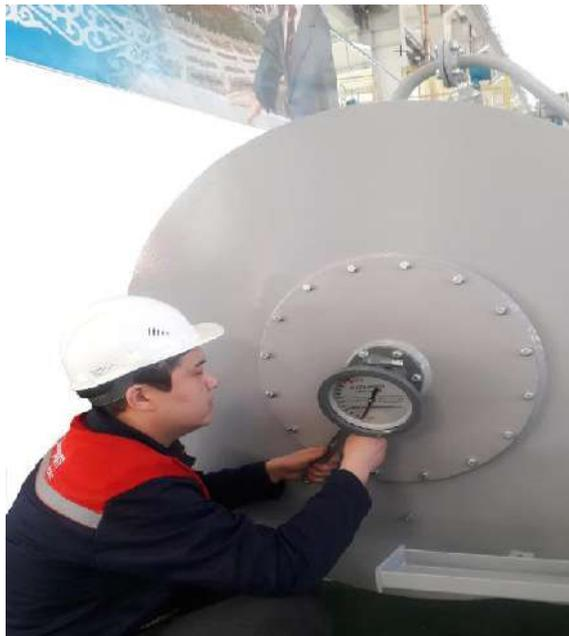
Рисунок 4.9 Установка маслоуказатель на расширитель
