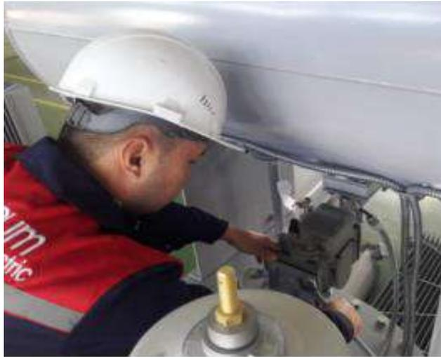
Рисунок 4.10 Установка газового реле
