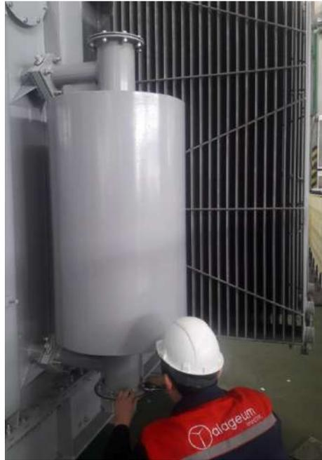
Рисунок 4.13 Установка термосифонного фильтра
