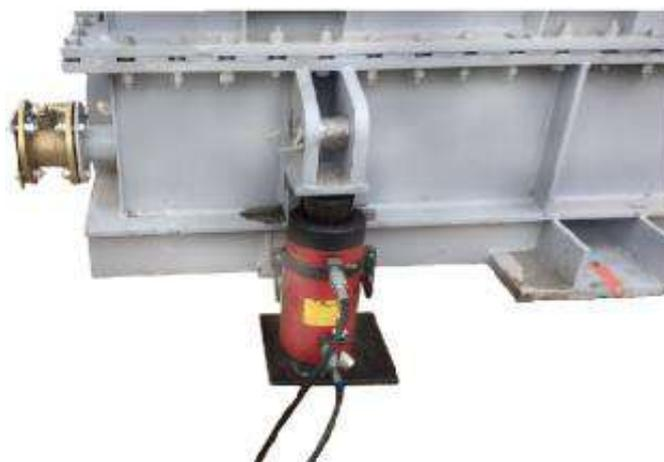
Рисунок 4.3 Поднятие трансформатор с помощью домкрата
