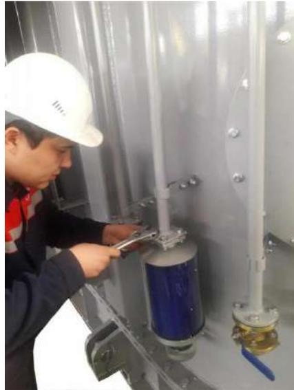
Рисунок 4.11 Установка воздухоосушителя
