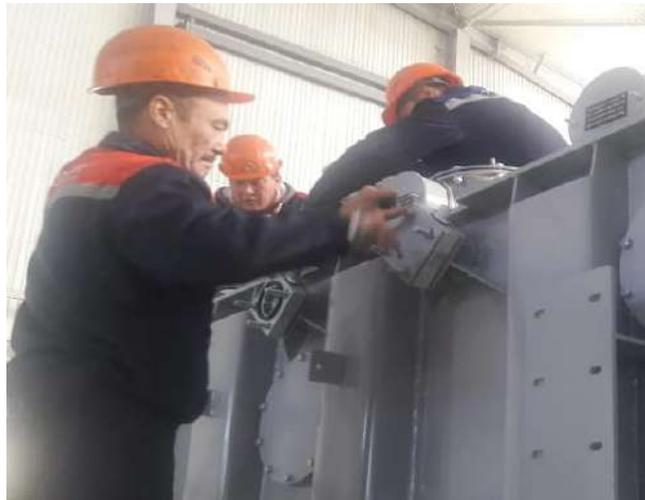
Рисунок 4.12 Подготовка для установки радиаторов
