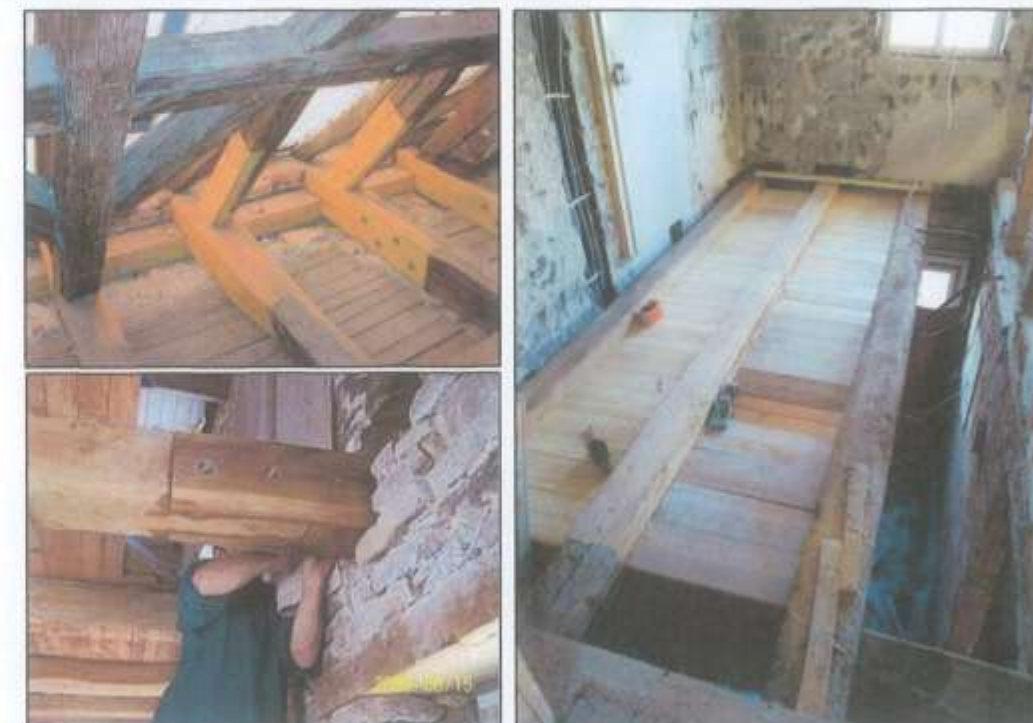
PROTEZARE BÂRNE ȘI CĂPRIORI DEGRADAȚI . FIGURA 4
