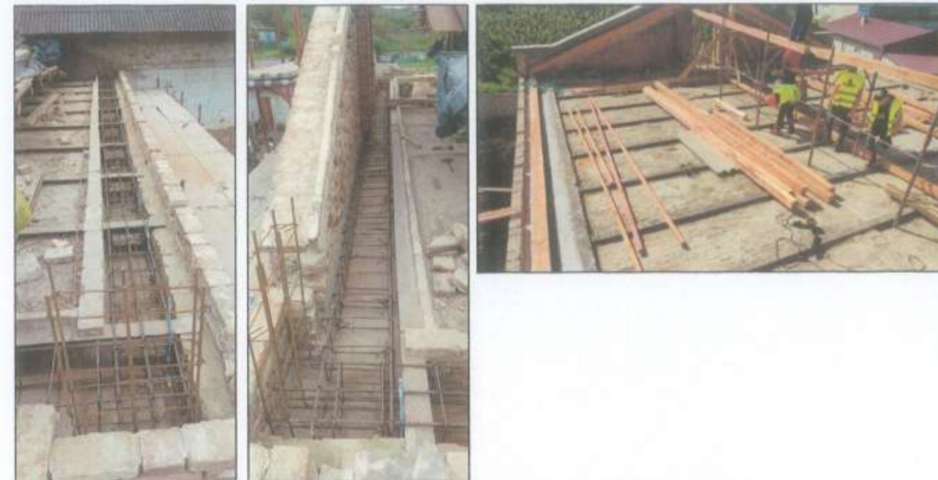
PROTEZARE BÂRNE ȘI CĂPRIORI DEGRADAȚI . FIGURA 4
