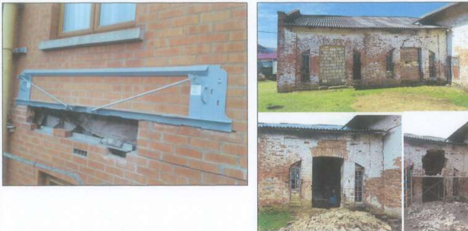
PLOMBAREA ZONELOR LIPĂ SAU DEGRADATE. FIGURA 2
