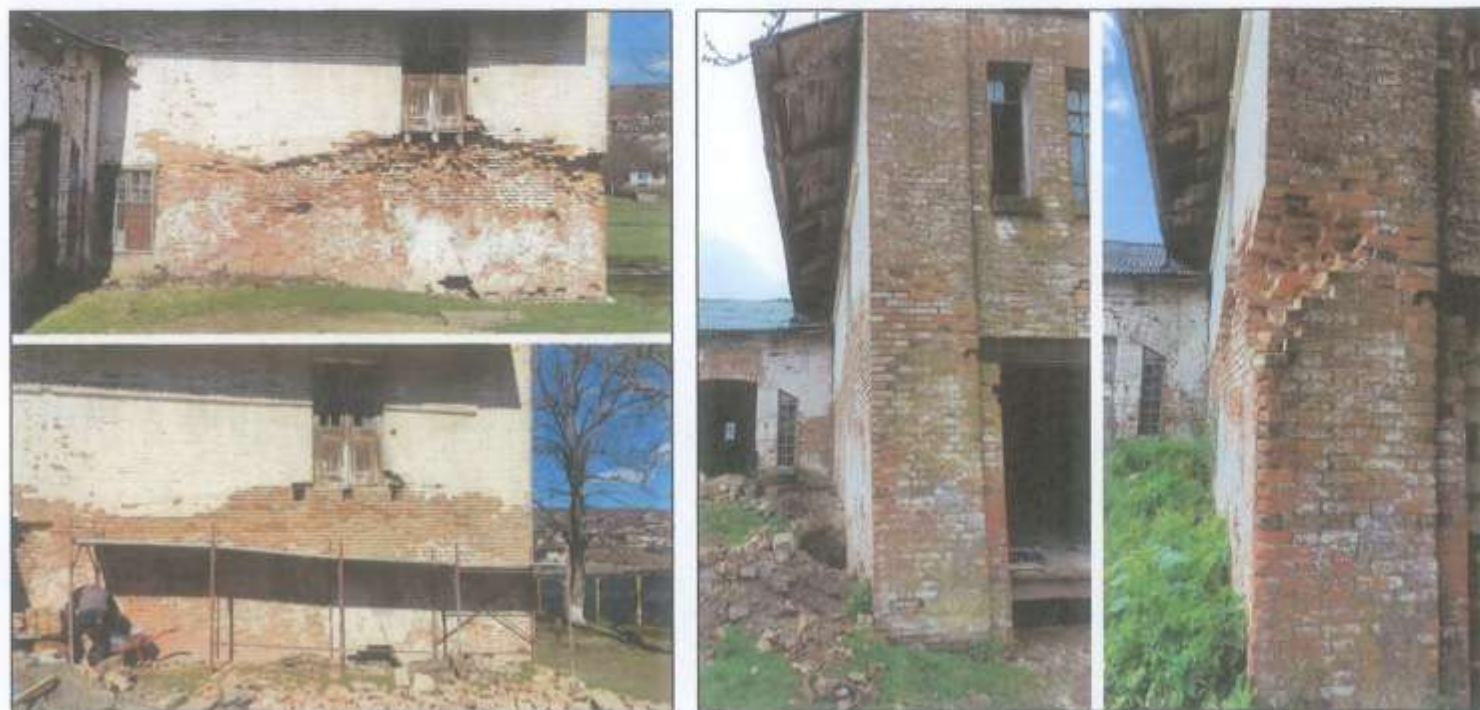
PLOMBAREA ZONELOR LIPĂ SAU DEGRADATE. FIGURA 2
