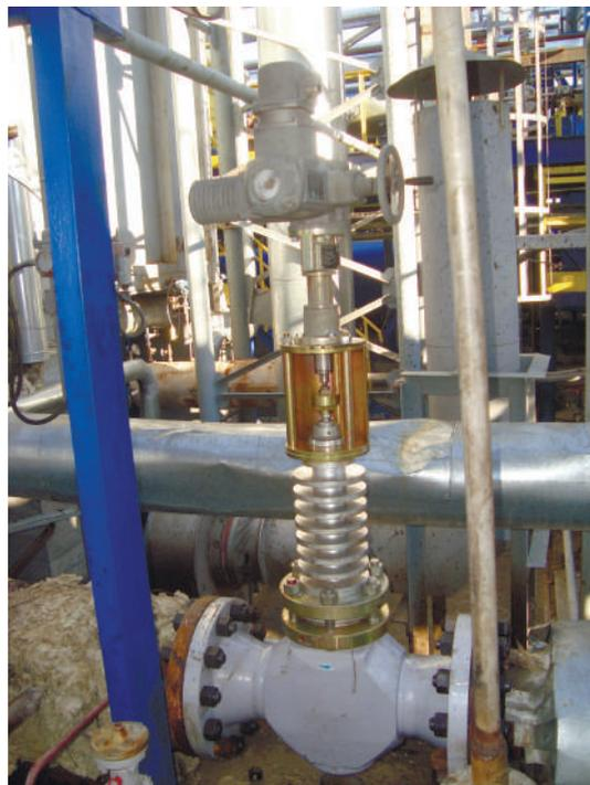
*Высокотемпературный клапан с электроприводом*
