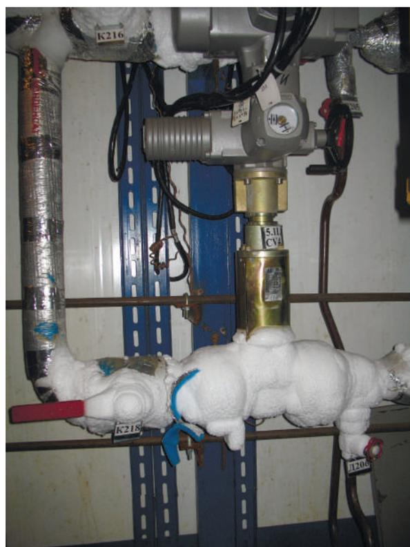
*Криогенный клапан с электроприводом*
