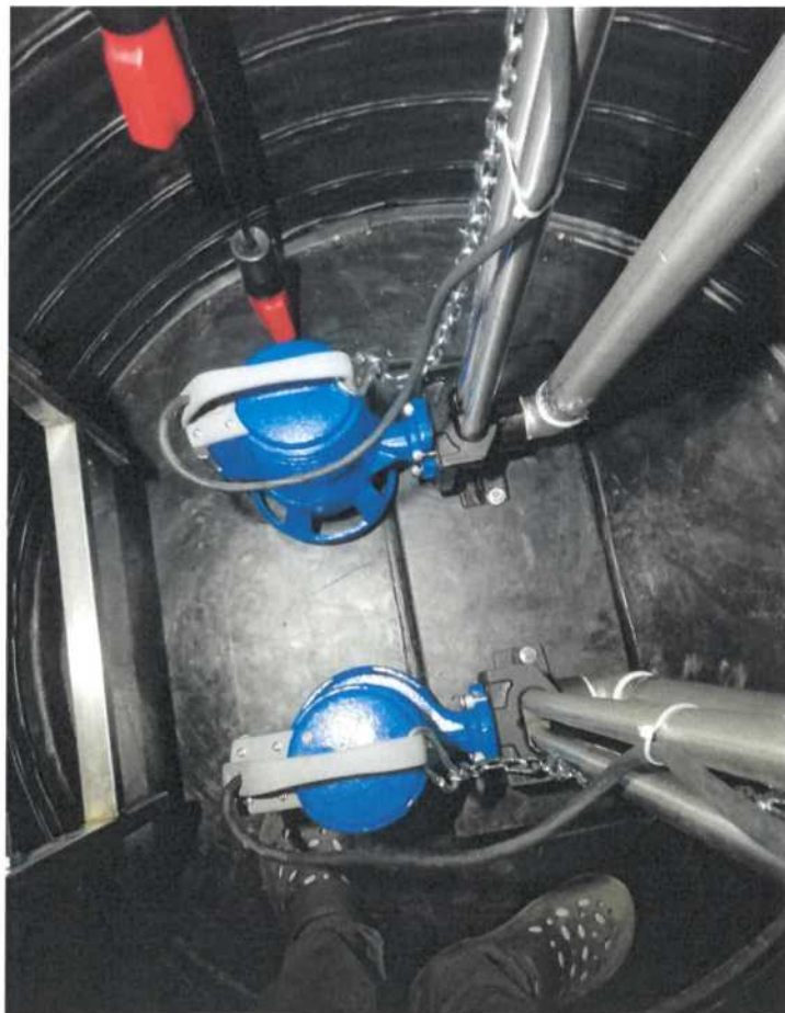
Figura 3: Specimen de încercare - pompe și țeavă de refulare din oțel inoxidabil
