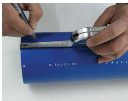
Măsurați și marcați țeava
