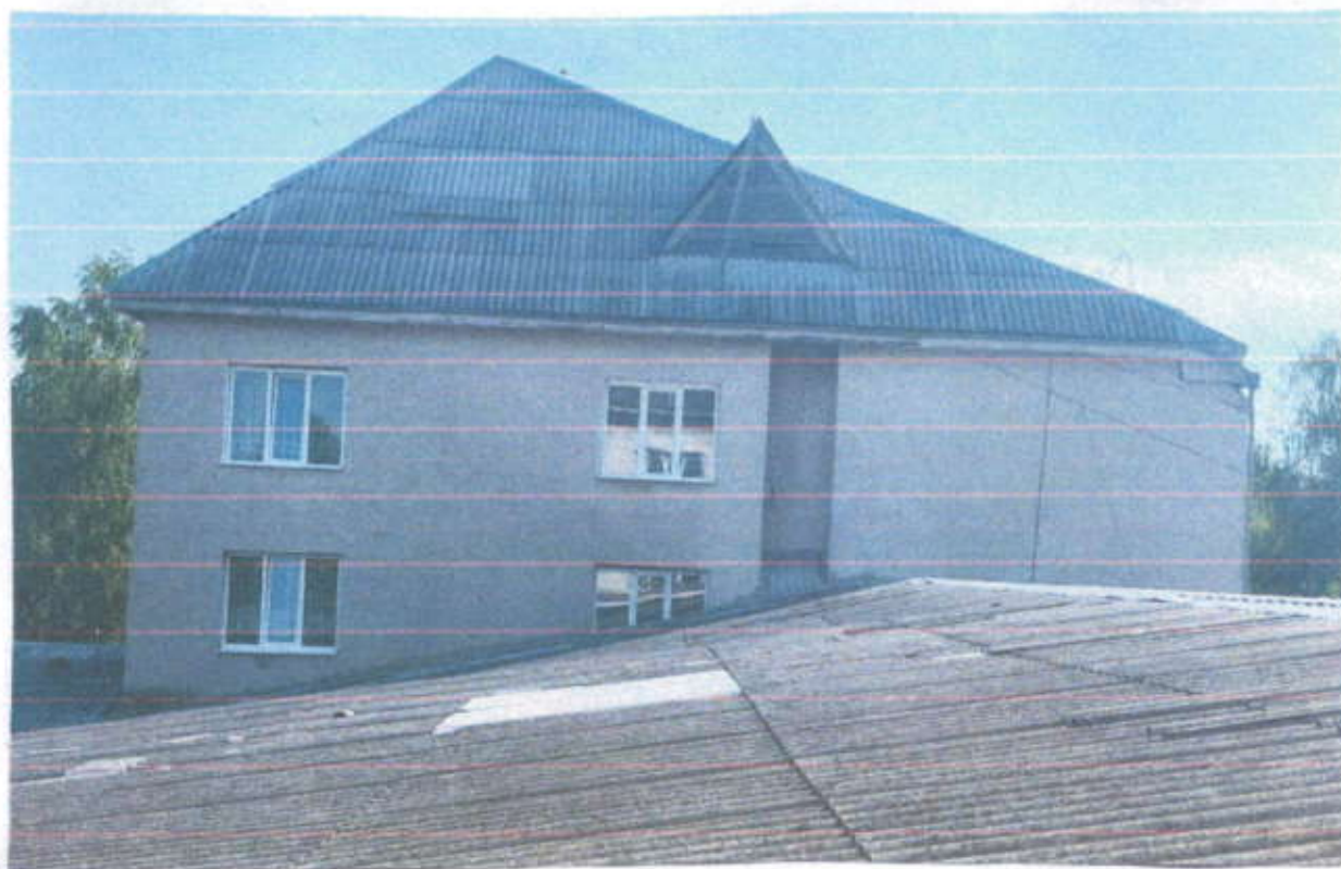
ФОТО 8. ВИД КОНТУРА КРЫШИ НАД БЛОКОМ 2
