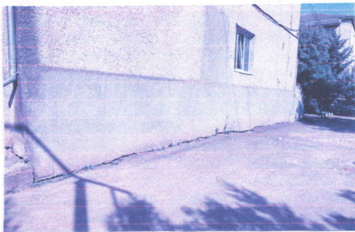
ФОТО 24. То же, по поперечной оси А. Рекомендуется повсеместно отмостку вскрыть, уплотнить и восстановить /возможно по методике, приведенной на листе 19/
