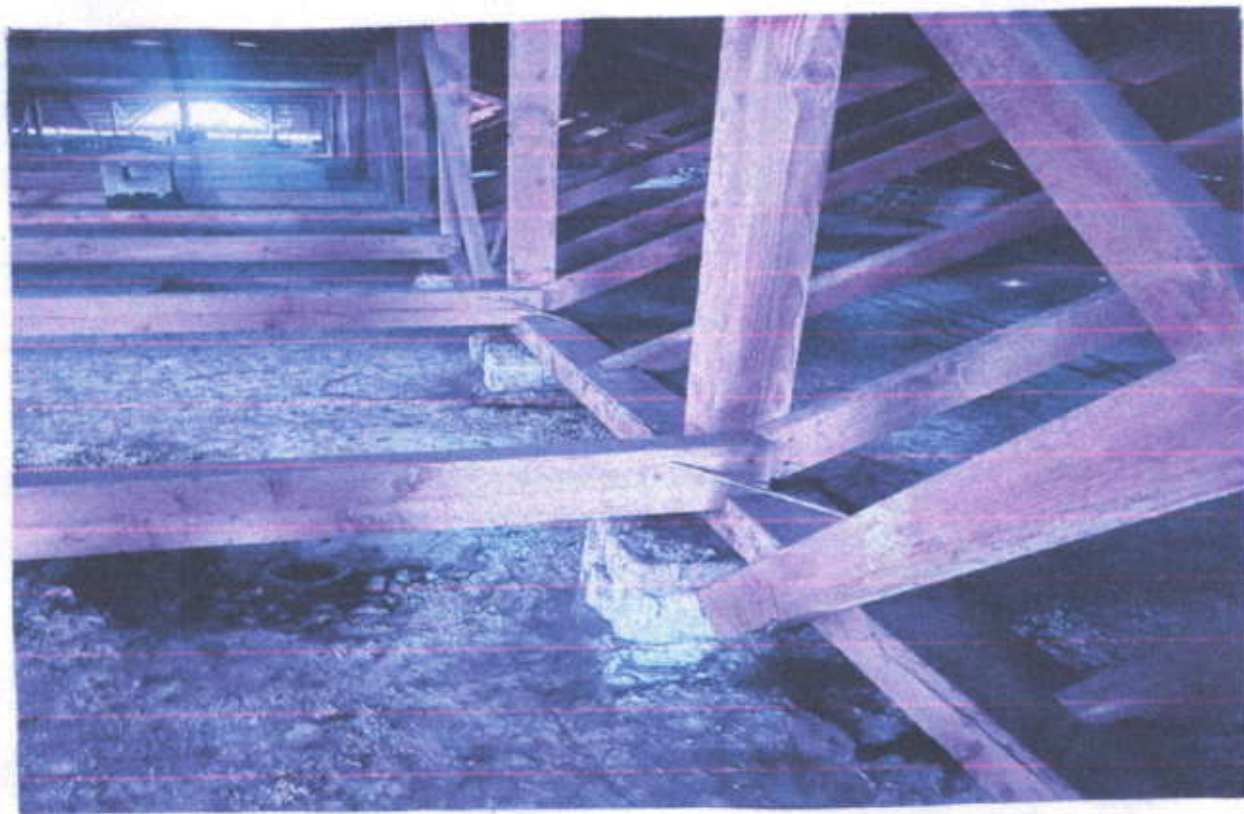
ФОТО 16. То же, торизонтальных прогонов и узлов сопряжения элементов крыши
