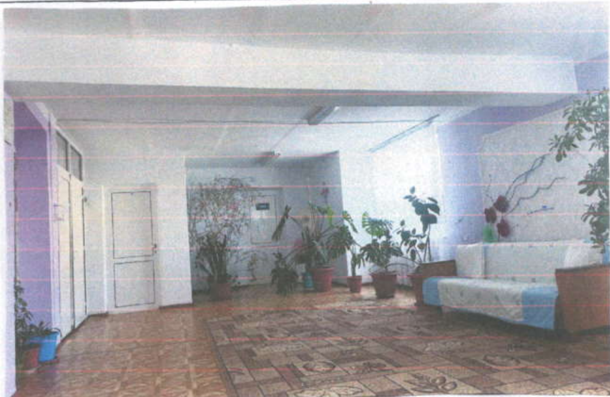
ФОТО 9. Вид состояния одного из вестибюлей в составе помещений Блока 2
