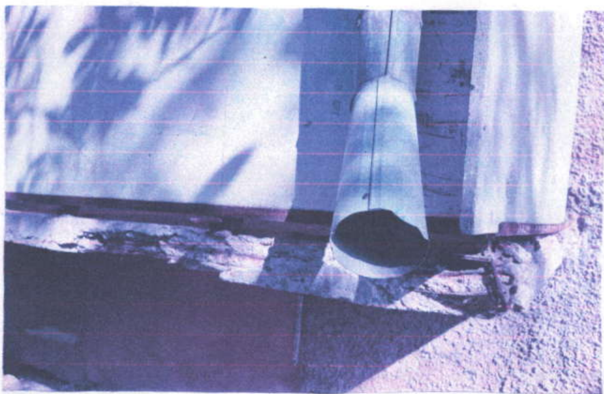
ФОТО 28. ПРОИЗВЕСТИ РЕМОНТ БАЛКОННЫХ ПЛИТ С ОГОЛИВШЕЙСЯ АРМАТУРОЙ /СМ. ФОТО 27/
