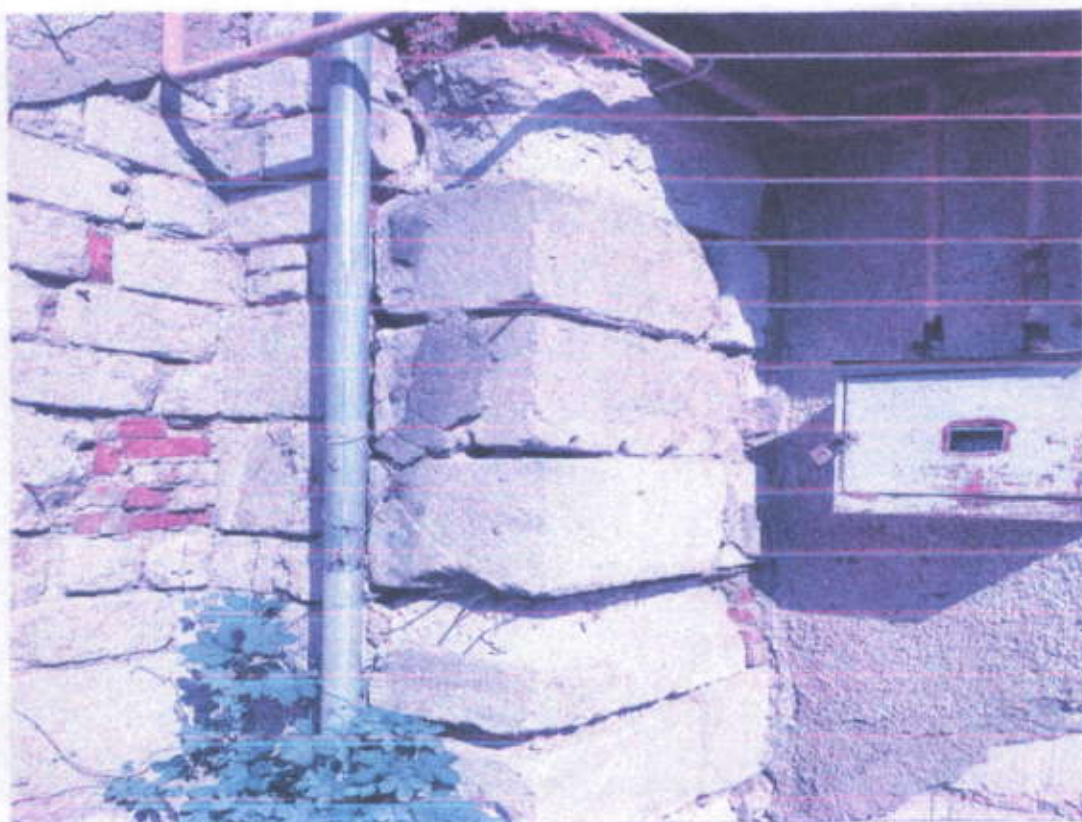
ФОТО 18. Поврежденный участок торцевой стены в уровне партерного этажа рекомендуется усилить по методике, приведенной на листе 17
