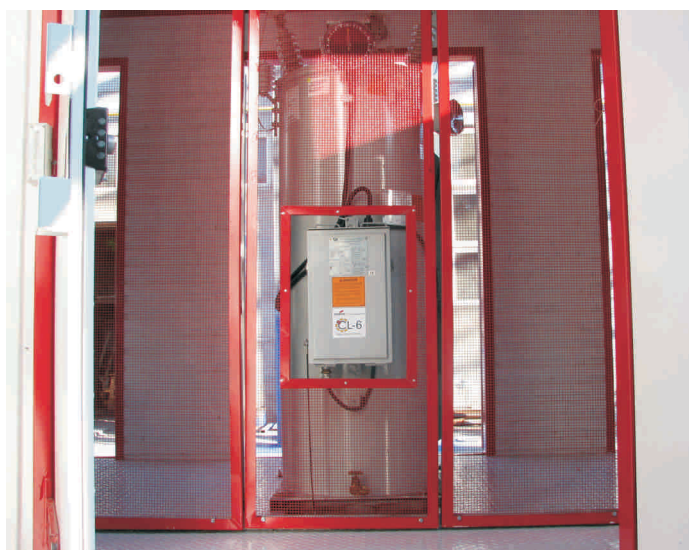
Рисунок 1. Блок автоматического регулирования напряжения 6-10 кВ
