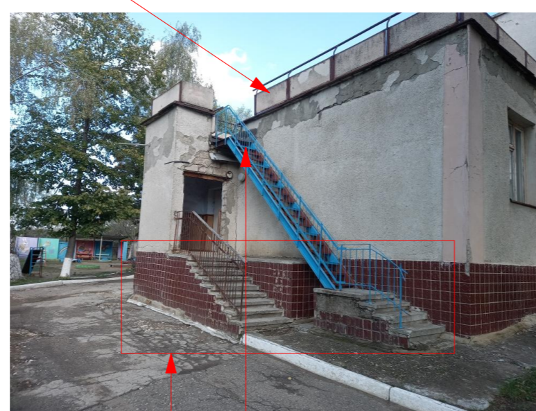
Scările din beton existente distruse se demontează, va fi construite noi
