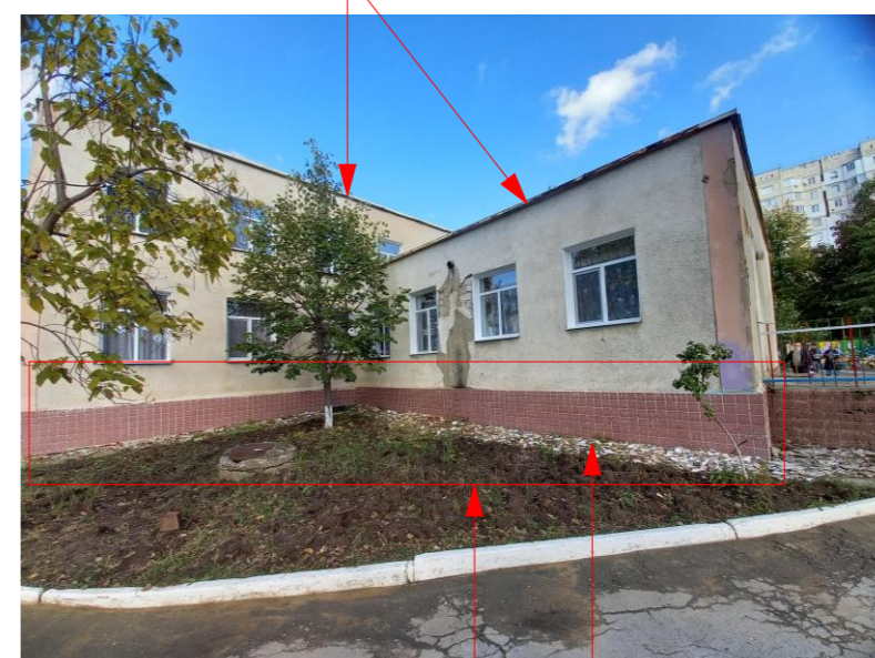
Placarea existentă a soclului - se demontează
