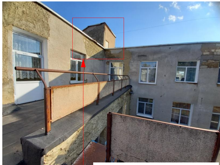
Casa scării (ieșire la acoperiș) se demontează
