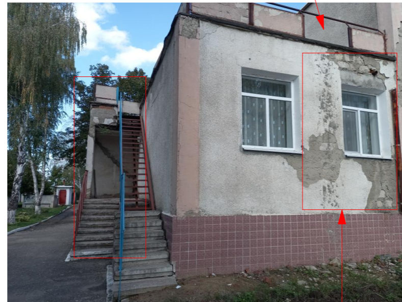
Tencuială existentă distrusă - se demontează parțial
