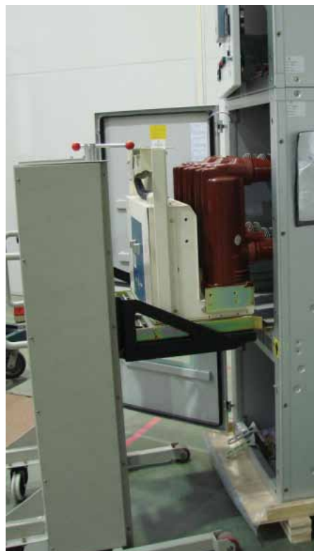
Рис. 5.1. Установка выключателя в распредустройство
