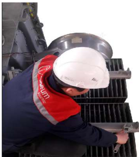
Рисунок 4.14 Открыть верхние пробки радиатора до появления масла
