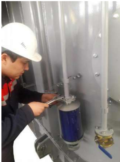
Рисунок 4.11 Установка воздухоосушителя
