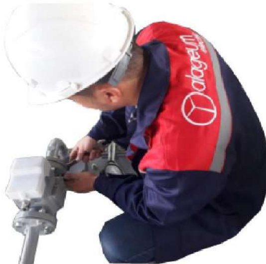
Рисунок 4.11 Установка струйного реле
