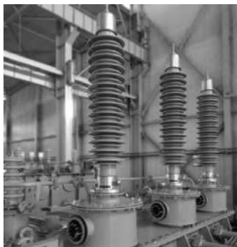
Изоляторы ВН-110кВ
