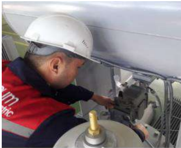
Рисунок 4.10 Установка газового реле
