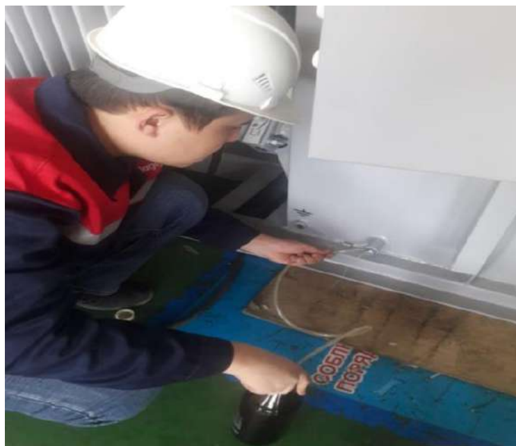
Рисунок 4.7 Отбор масла с бака трансформатора
