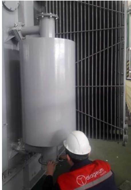
Рисунок 4.13 Установка термосифонного фильтра
