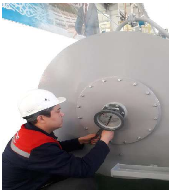
Рисунок 4.9 Установка маслоуказатель на расширитель
