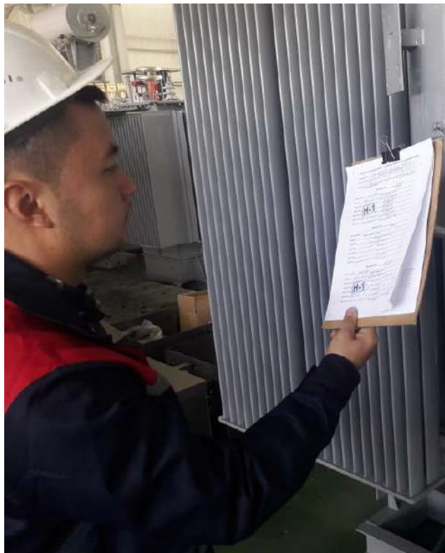
Рисунок 4.1 Ознакомление с паспортом и «Руководство по эксплуатации» трансформатора до монтажа
