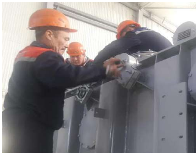
Рисунок 4.12 Подготовка для установки радиаторов
