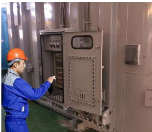
Рисунок 4.16 Монтаж кабелей на клеммную коробку
