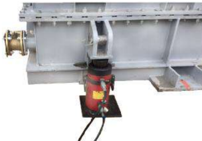
Рисунок 4.3 Поднятие трансформатор с помощью домкрата
