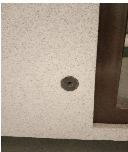
Рис.12 Место подсоединения внешнего контура заземлением к GALBOX.
