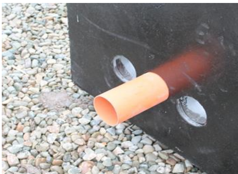
Рис.16 Монтаж пластиковой трубки в корпус фундамента GALBOX.
