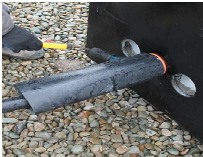
Рис.18 Нагревания термоусадочной трубки
