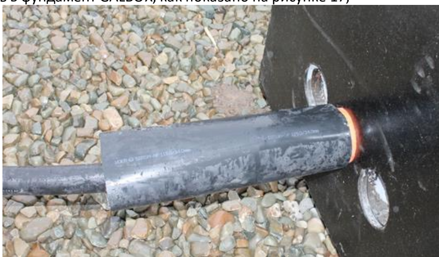
Рис.17 Монтаж кабеля в фундамент GALBOX
