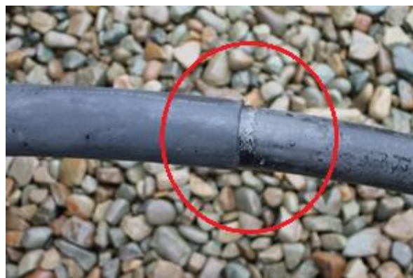
Рис.19 Выделение клея в процессе нагрева термоусадочной трубки
