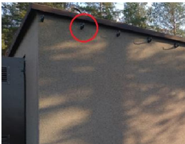
Рис.10 Крепления крюков желоба.
