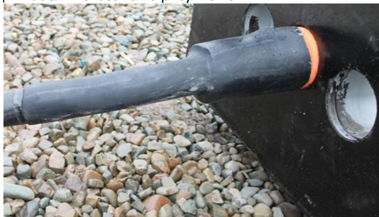
Рис.20 Пример выполнения герметизации кабельного присоединения.
