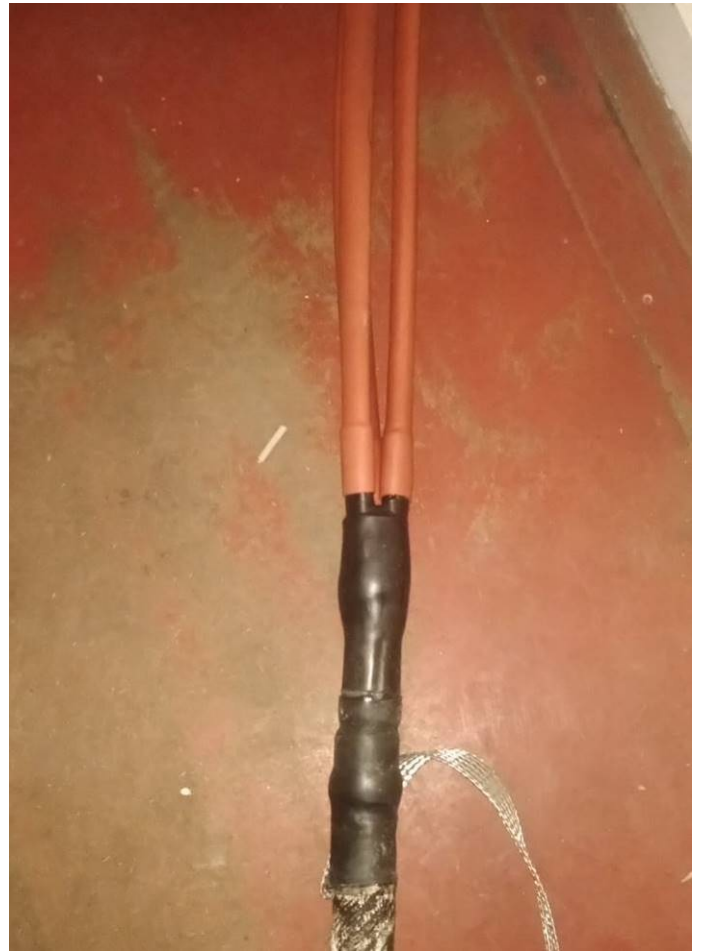
Рисунок 8.2 – Загальний вигляд термоусаджувальних кінцевих муфт типу 10КВ(Н)тп (зовнішнього та внутрішнього встановлення).
