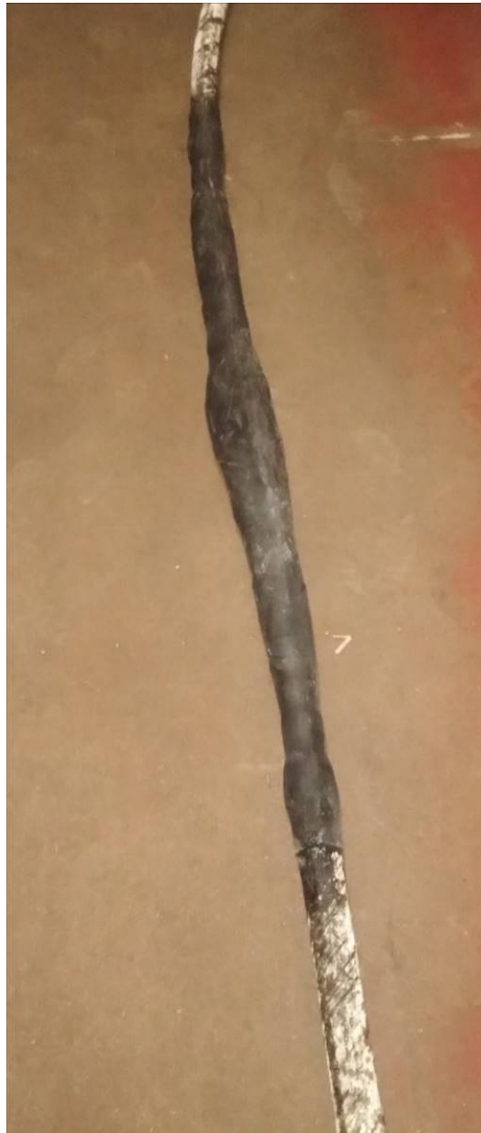
Рисунок 8.1 – Загальний вигляд термоусаджувальних з'єднувальних муфт типу 10СТп
