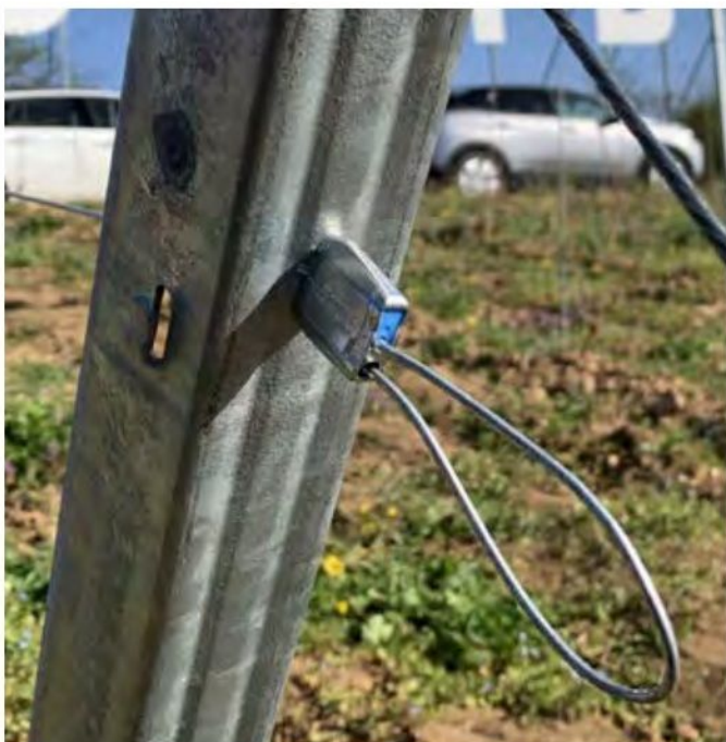
Instalat pe spalierii de metal
