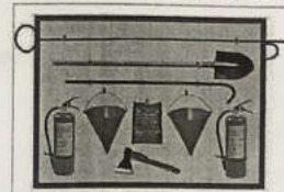
Fig.1 Panoul antiincendiar va conţine următoarele elemente: topor (2), lopată (2), hirtle (2), cangă (1), rangă (1), căldare conus (2), stingător de foc (2), nisip (0,5 m 3 ).
