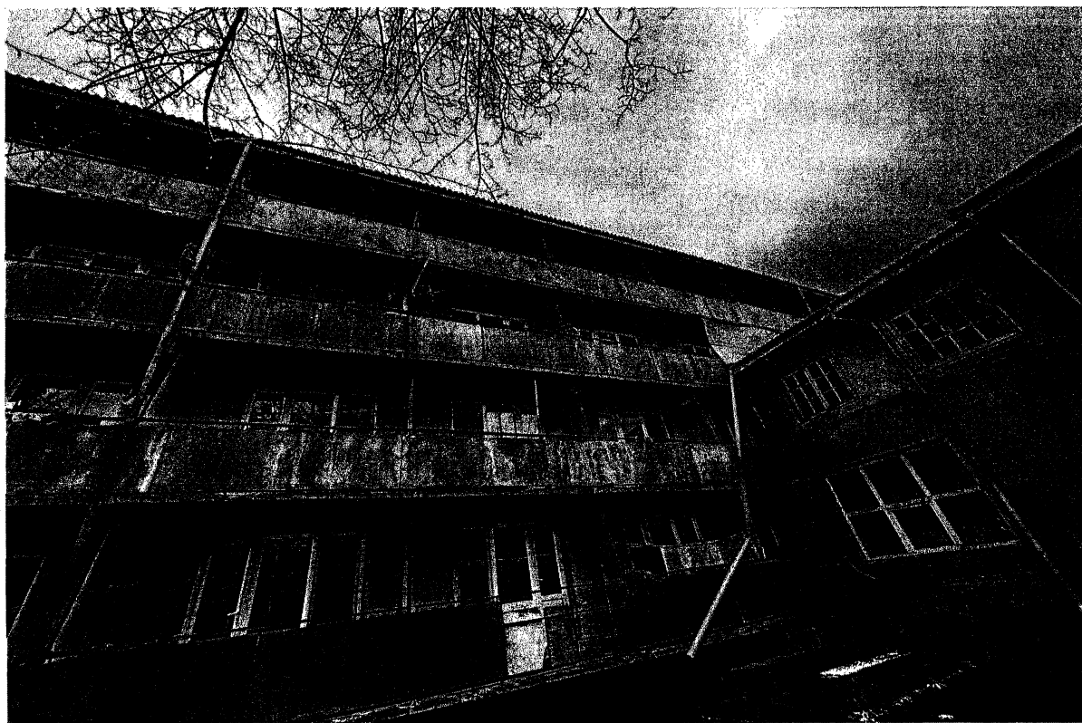
ФОТО 11. ВИД СОСТОЯНИЯ ОКОННО-БАЛКОННОГО ОТРАЖЕНИЯ И ВОДОСТОЧНЫХ ТРУБ
