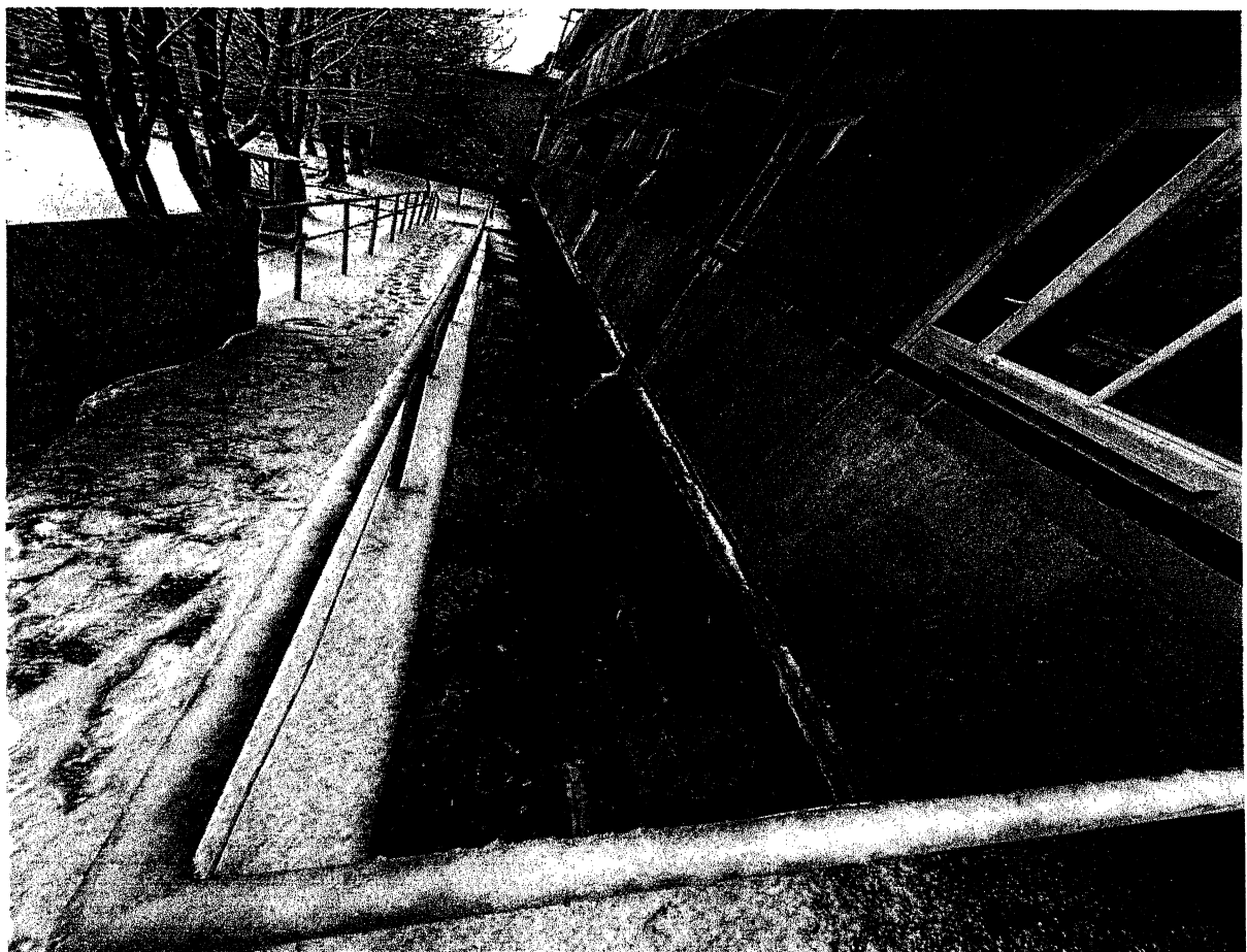
ФОТО 2. ФРАГМЕНТ СТЕНЫ ПАРТЕРНОГО ЭТАЖА; АТМОСФЕРНЫЕ ОСАДКИ СКАПЛИВАЮТСЯ НА ОТ- МОСТКЕ У СТЕНЫ
