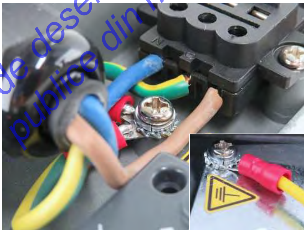
M60W36L505057CRI70KHP10D6I60TDD2CLI puncte de împământare
