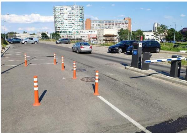
В тех случаях, когда число существующих полос движения превышает одну, или существующие полосы значительно шире, чем одна стандартная полоса движения, эксперты предлагают установить пластиковые барьеры, которые сужают ширину полос движения. При необходимости (например, при транспортировке негабаритных грузов) такие барьеры могут быть демонтированы и впоследствии повторно установлены.
